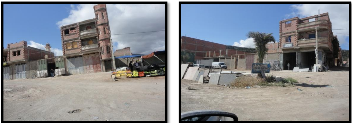
Photos.18 : Implantation de constructions illicites sur la double voie.
