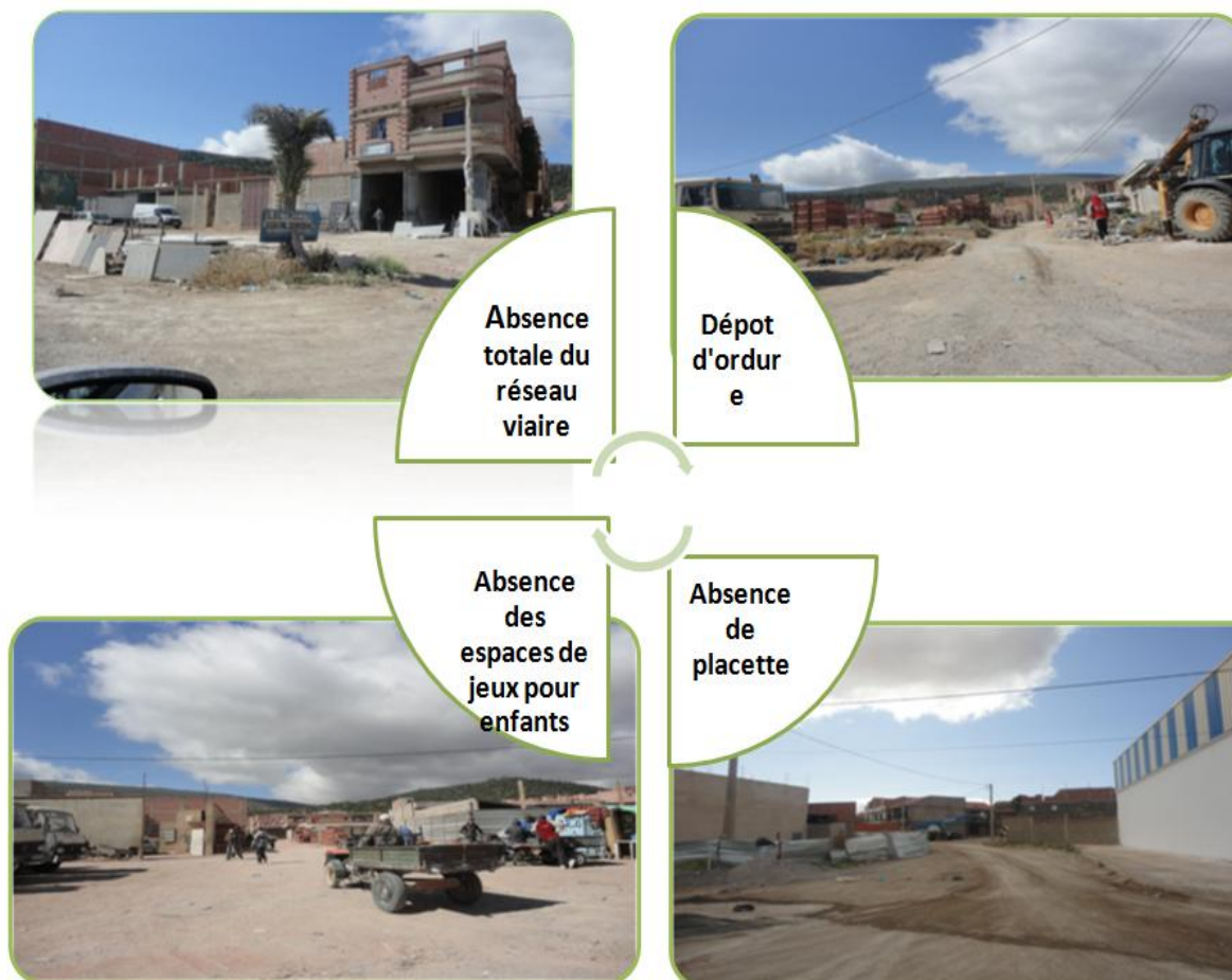
Photos.21 : Absence des aménagements extérieurs
