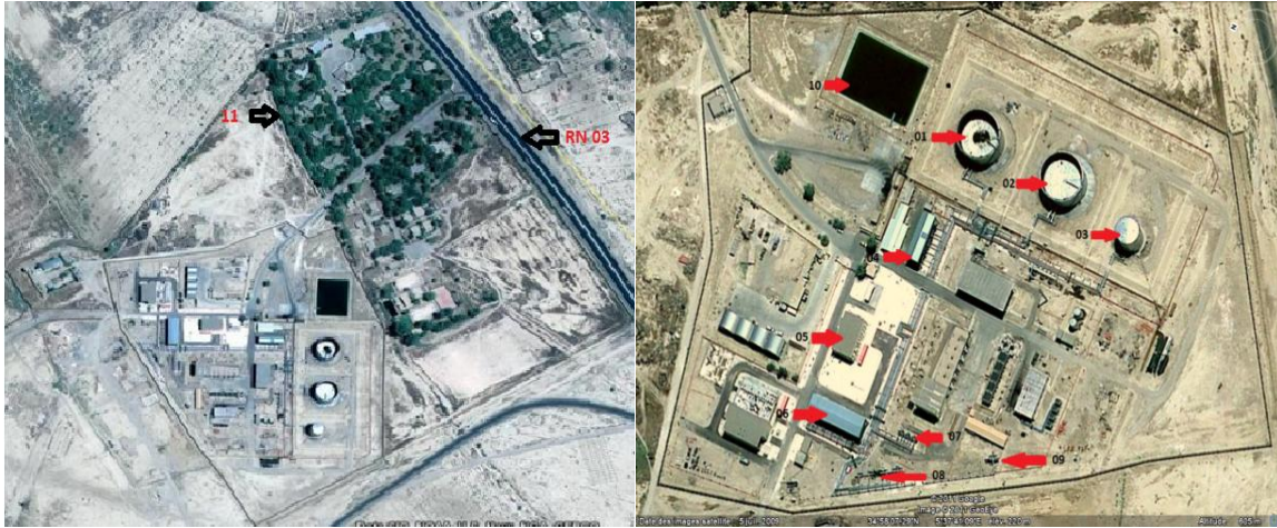
Fig. III.3. La station de pompage N°2. (image Google earth )
