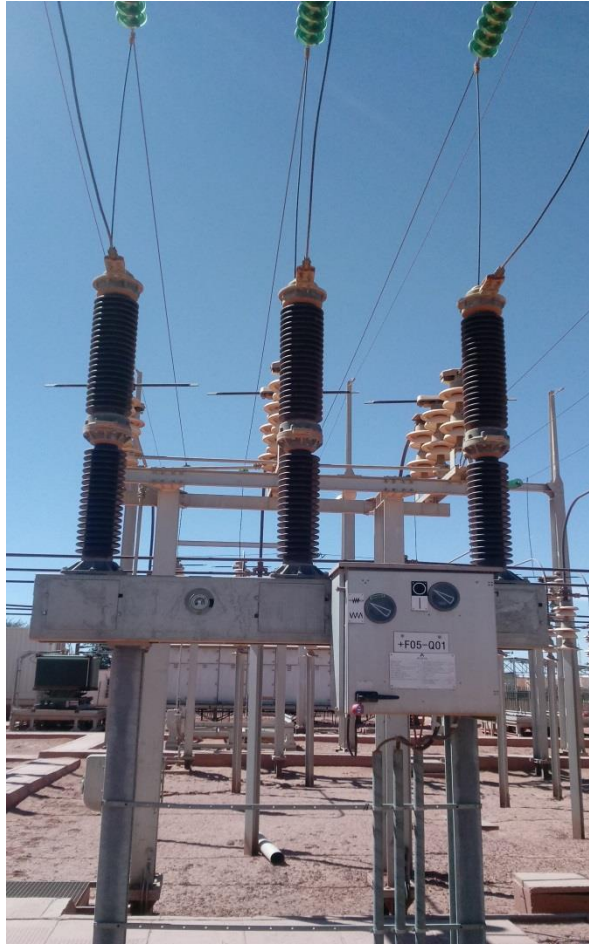
Figure.2.7. Disjoncteur à gaz SF6
