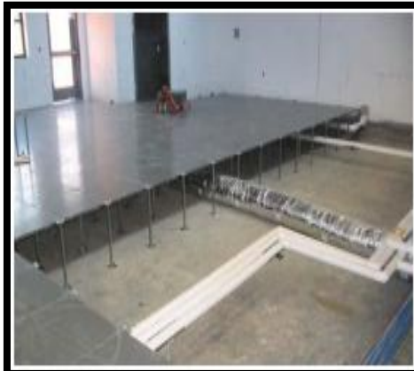
الصورة رقم (4.1.2.11) : يوضح نظام توزيع الهواء تحت الارض في فراغات مدرسة فورك .
