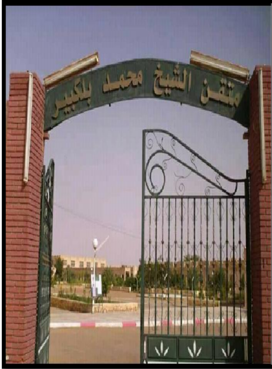
صورة (11-30) :مدخل المتقنة يظهر الفراغات الداخلية للمتقنة (ساحة تجمع الطلبة)
