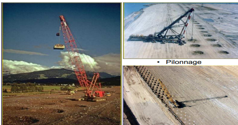
Figure I.3 technique de compactage dynamique,(Magnan2010)
