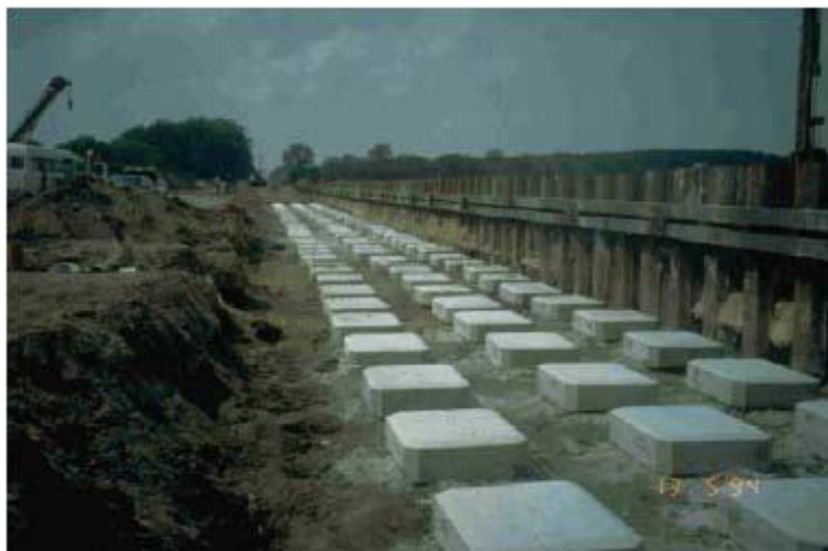
Figure II.3 – Chantier de remblai ferroviaire, visualisation des têtes d'inclusion avant l'édification du remblai,(Zanziger et Gartung2002).
