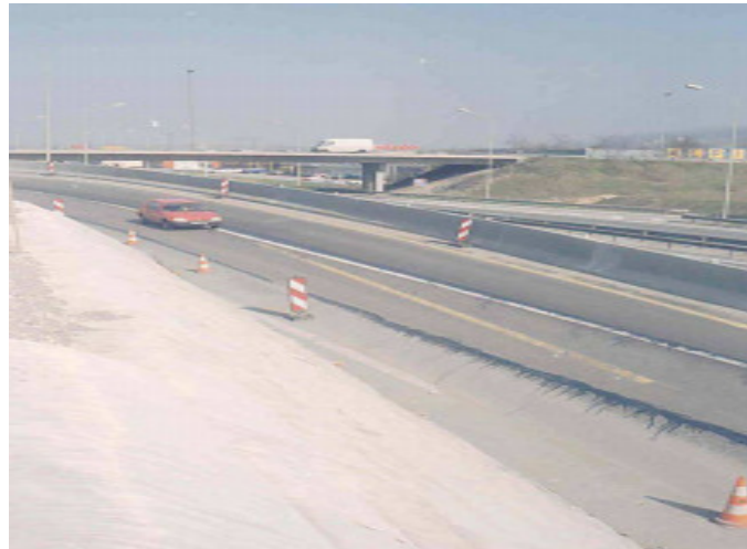
Figure II.8 Remblai d'accès de l'autoroute A43 – Chambéry.France .(terrasol2010)
