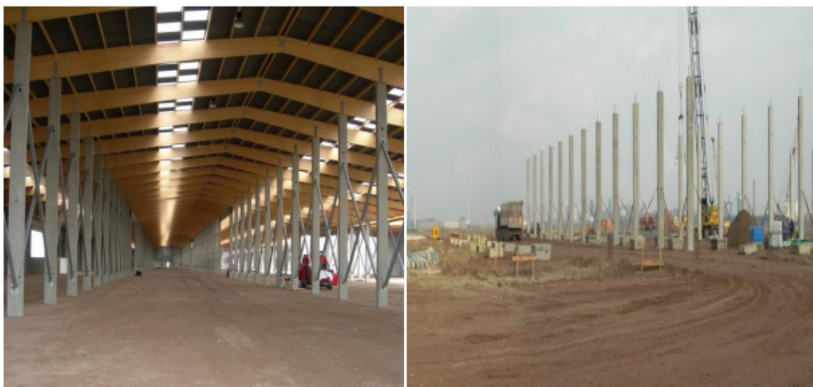
Figure II.7 Pieux battus en béton préfabriqués. Hangars pour stockage, Belgique2006, (BOUSMAHA2017)
