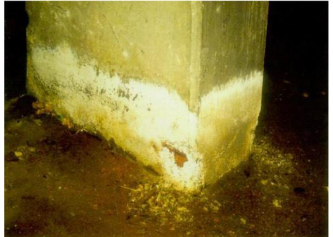
**Figure 18-B** : Attaque sulfatique externe ( pile du pont )
