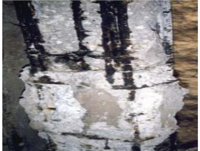
**Figure 36** : Béton détérioré par une attaque par les sulfates (90 logements Biskra) [10]
