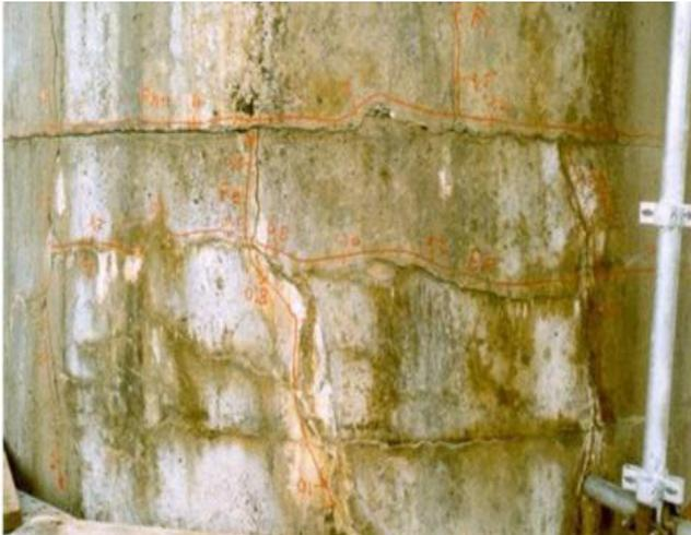
**Figure 18-A** : fissuration multidirectionnelle localisée sur la face verticale à l'extrémité d'un chevet de pont
