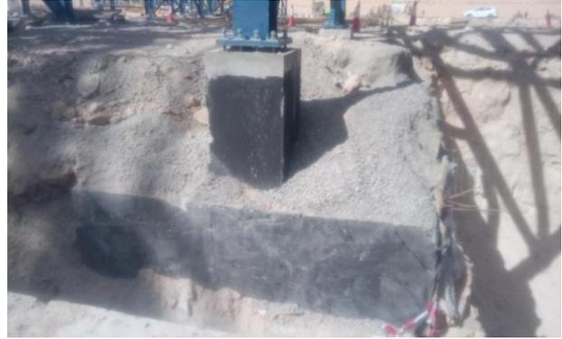
Figure 20 -D : Une semelle isolée (flintkote)
