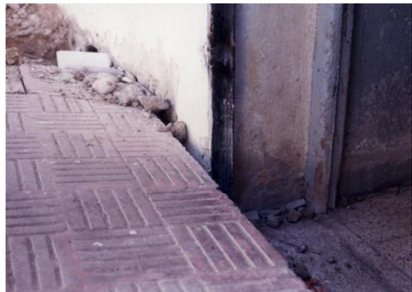
Figure 35 : Abaissement dans le sol provoquant une élévation des trottoirs
