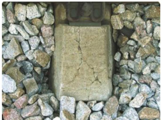
**Figure 18-D** : Extrémité d'une traverse de chemin de fer présentant un réseau de fissures provoquées par une RSI
