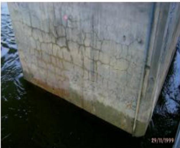
**Figure 18-C** : Fissuration très marquée dans la partie de la pile en contact avec l'eau
