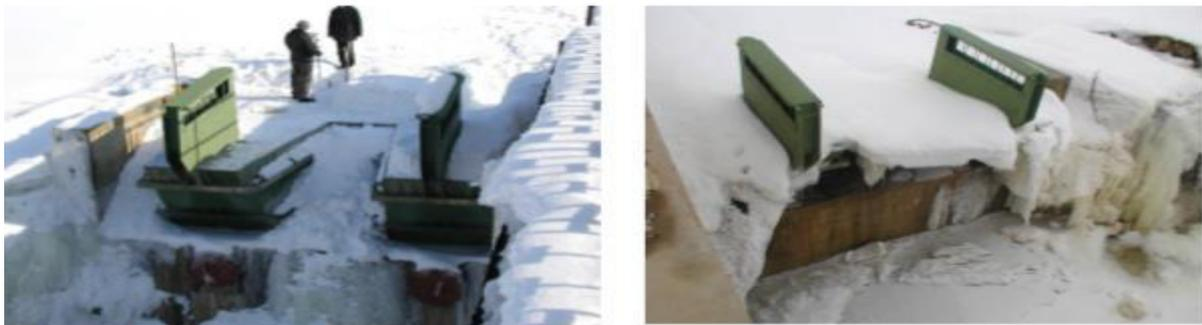
**Figure (I.17)** Hausses fusibles sur le barrage de Khorobrovksaya.
