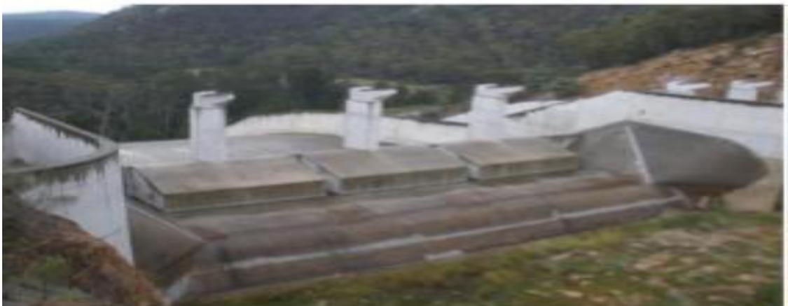
**Figure (I.14)** Vue amont des hausses à crête rectiligne (Hydroplus)
