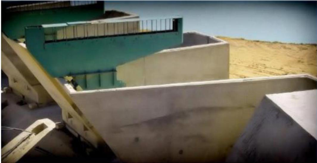
**Figure (I.21)** Puits d'alimentation solidaire de la hausse (en acier).
