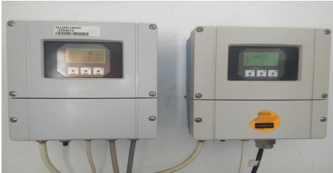
**Figure (III.6)** Débitmètre à ultrason Flowmeter 93W2
