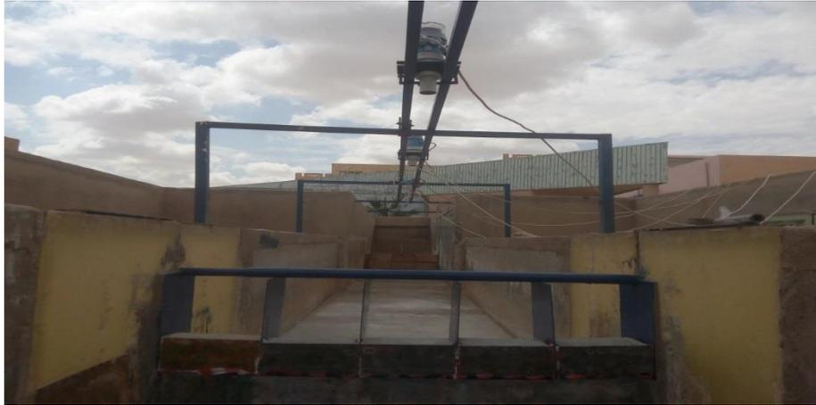
**Figure (III.9)** DéTECTEUR de niveau à ultrason au niveau du canal
