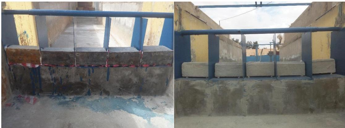
**Figure (III.15)** Vue amont et aval des blocs posés sur les pertuis
