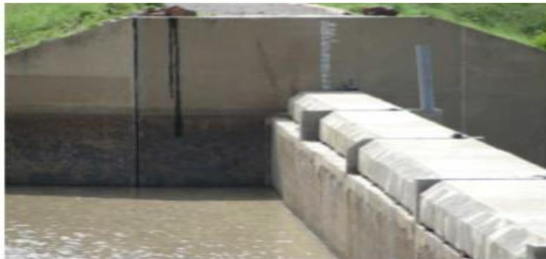
**Figure (I.34)** Vue en perspective d'un déversoir Blocs fusibles (Hydroplus).
