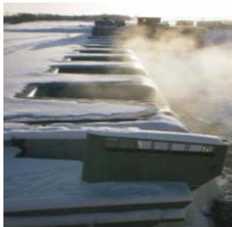
Figure (I.16) Hausses fusibles sur le barrage de Khorobrovksaya.
