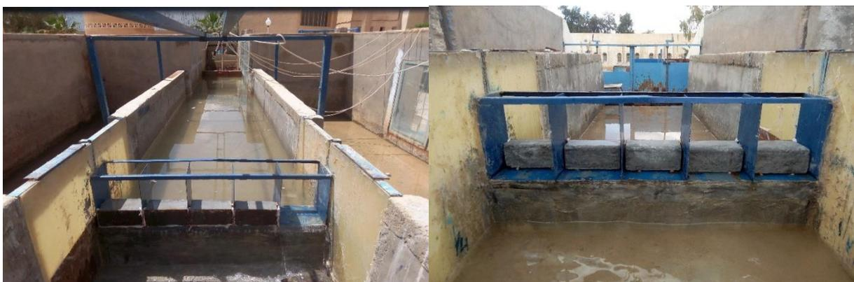
Figure (III.20) Déversoir avant et après le basculement d'un bloc
