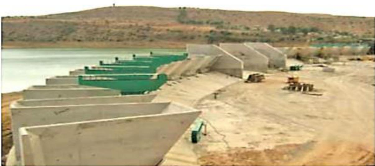
**Figure (I.10)** Hausses fusibles à seuil labyrinthe, barrage Ghrif en Algérie (hydroplus, France).
