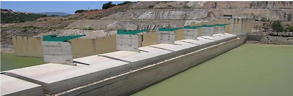
Figure (I.15) vue amont des hausses à crête rectiligne barrage de Béni Amrane.
