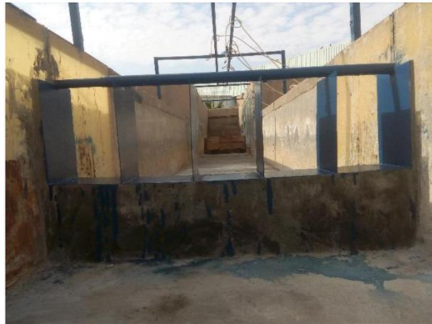
Figure (III.13) Socle de basculement des blocs
