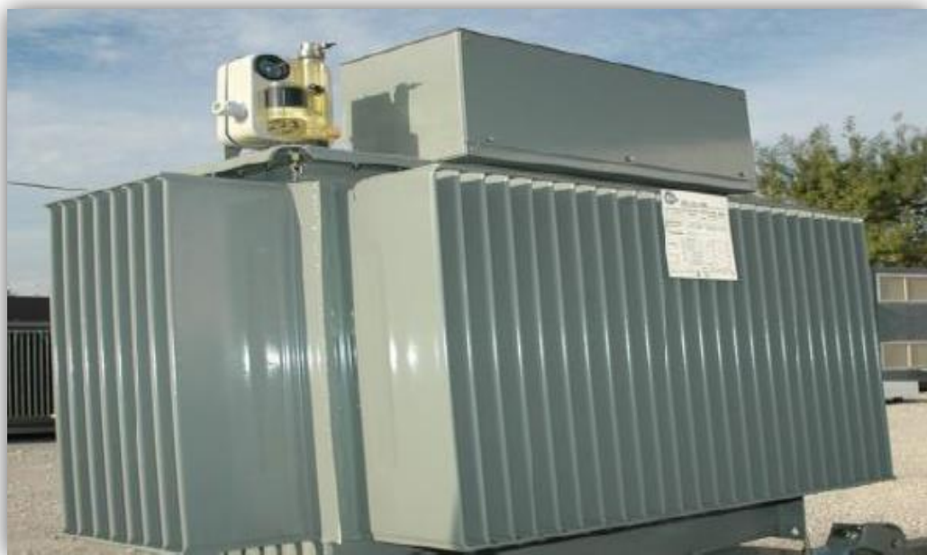
Fig. I.19. La cuve d'un transformateur de puissance [2].
