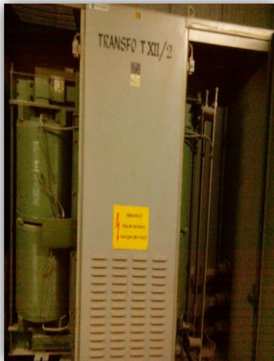
Fig. II.13. Transformateur à sec 10/0.4KV
