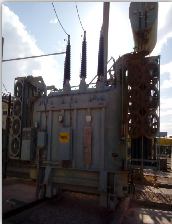
Fig. II.3. Transformateur à huile 60/10KV
