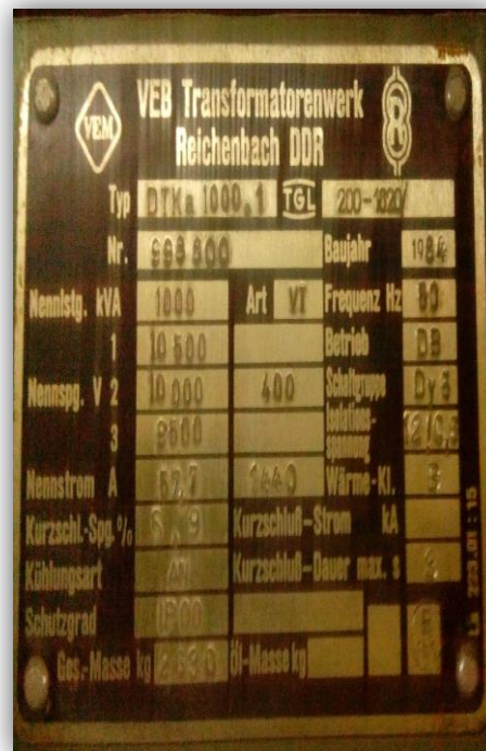
Fig. II.13. Transformateur à sec 10/0.4KV
