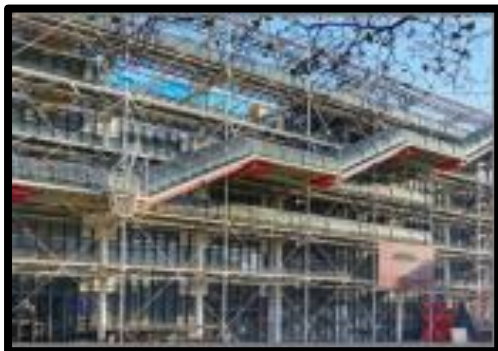
الصورة رقم 22 : نظام الهياكل الشبكية – المصدر
