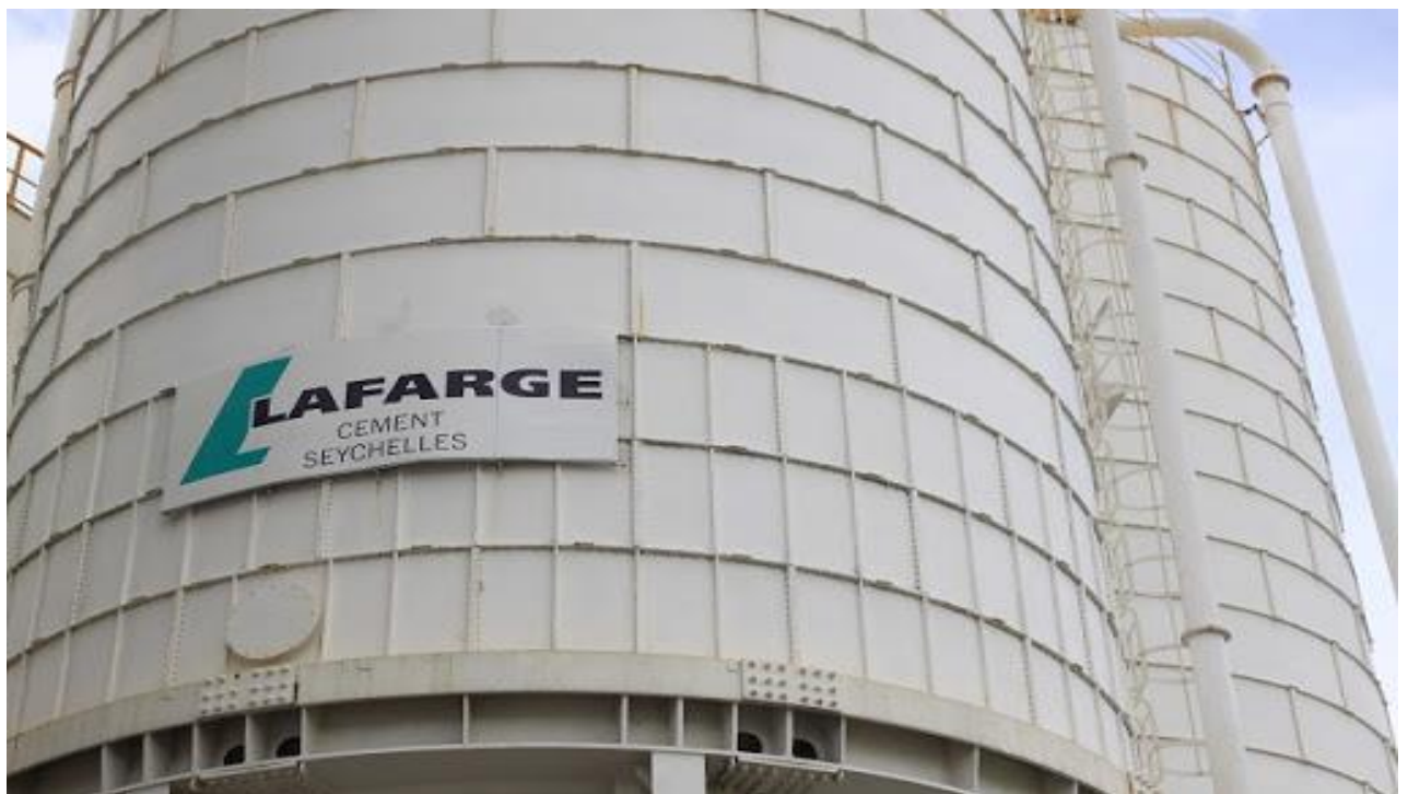
Figure 1.10 : silo de stockage
