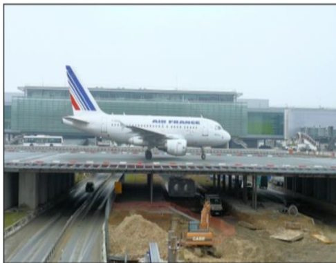
Figure 53. Pont-avion à l'aéroport de Roissy-Charles-de-Gaulle
