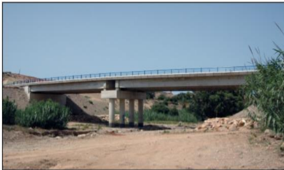
Figure 55 Pont à poutres à travées indépendantes en béton armé
