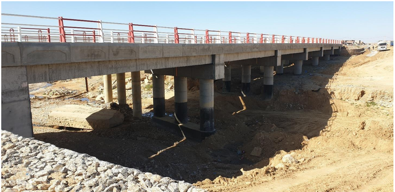
Figure 65 : Vue latérale du pont du projet
