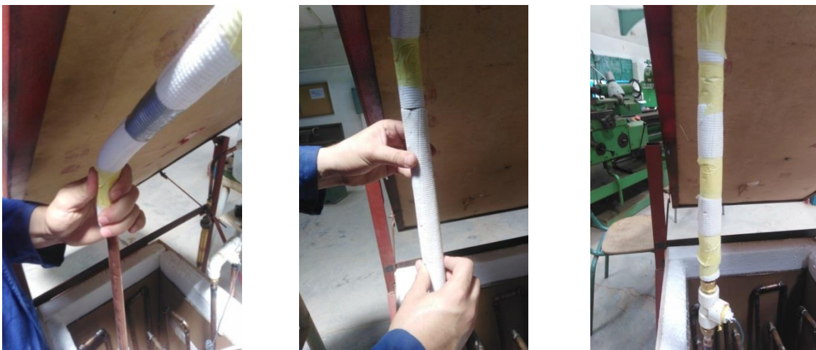
Figure III.11 : isolation des conduites de raccordement.
