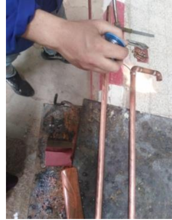
Soudage par flamme de chalumeau à l'étain
