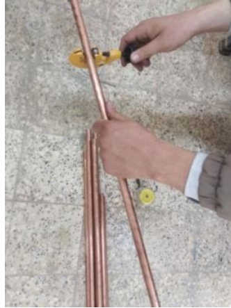
Découpage des tubes en cuivre
