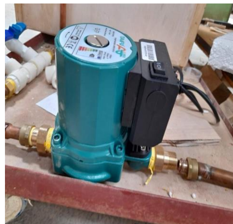
Figure III.9 : Pompe à eau de type Shimge home booster.
