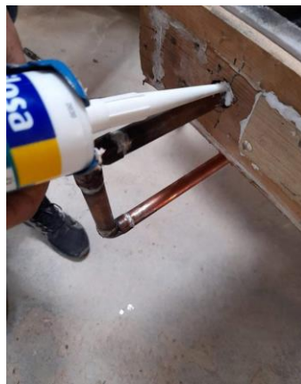
Figure III.4 : réalisation de l'isolation.
