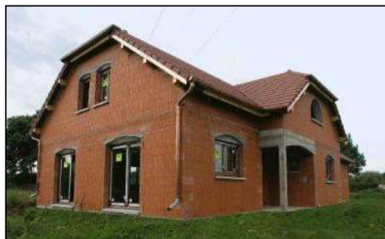
Figure 17 : L'enveloppe en remplissage maçonné Source : http://ericjarrot.free.fr/photographie.5.htm
