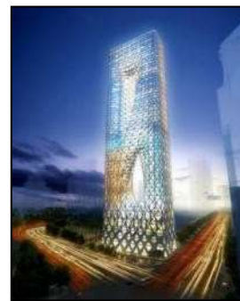
Figure 35 : Sunrise Tower à Kuala Lumpur Source : Google image
