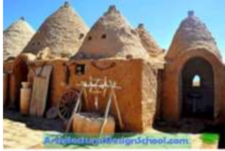
Figure 6 :Maisons de ruches de Harran, Turquie construites en adobe, en brique et en pierre SOURCE :www . architecturaldesignschool.com
