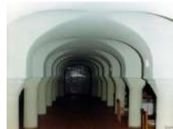
Figure72 : Une voûte d'arête dans le restaurant de l'hôtel Marhaba Laghouat .source : sara zinddine 2019.
