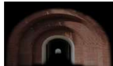
Figure73: Une voûte sphérique dans l'entrée l'hôtel Marhaba Laghoua.source : sara zinddine 2019 .
