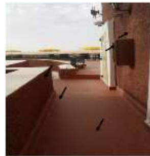
Figure :les maçonneries dans l'hôtel gourara.source : https://www.google.com/search?q=hotel+gourara
