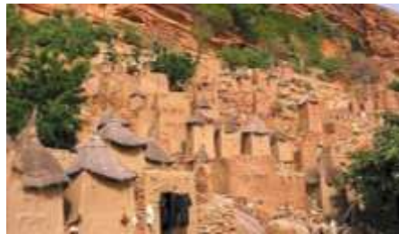
Figure7 :Falaise de Bandiagara, Mali 289 villages de constructions en terre Source :www.architecturaldesignschool.com
