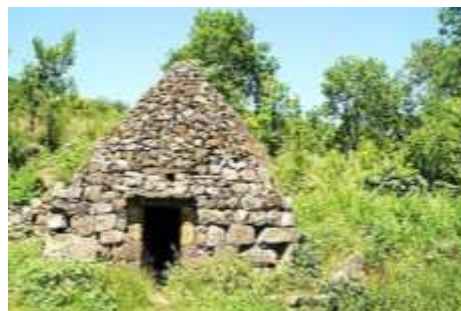
Figure 5 : Chibotte, en France, la chibotte est une cabane en pierre sèche Source : www.architecturaldesignschool.com
