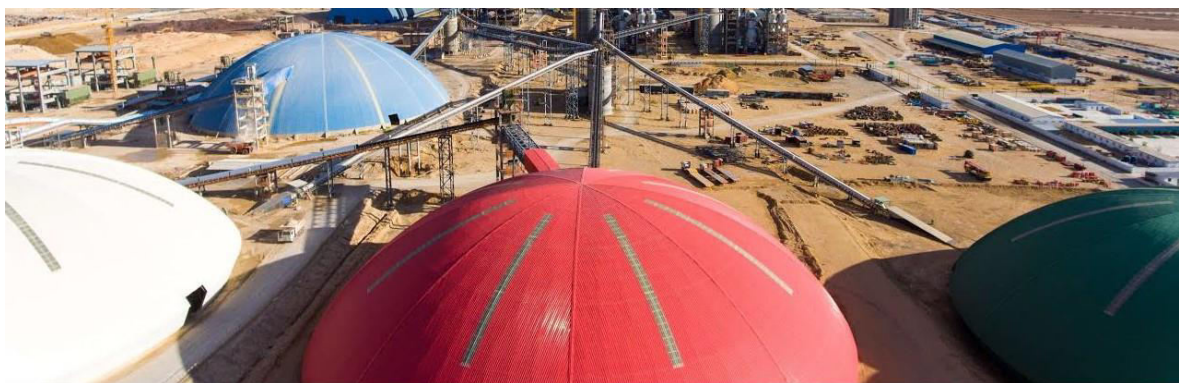
Figure I.3 : Photographie montrant les polars de stockage [3]
