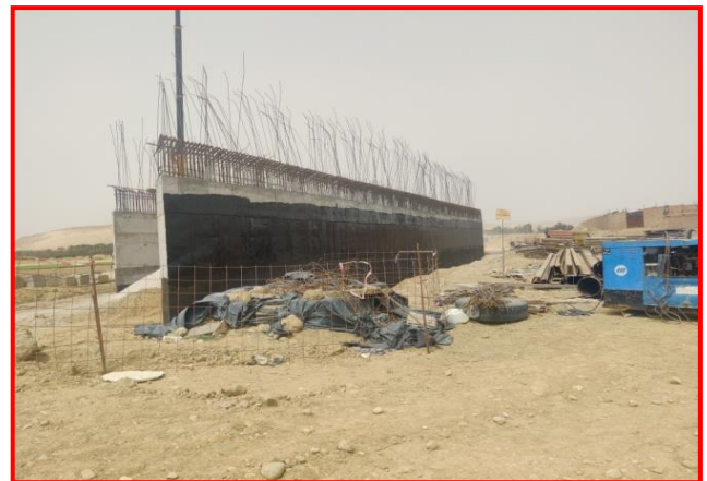
OA PK 14+134 : Travaux de coulage de voûte culé 4 ème levé côté EL-GOURZI et TOUGGOURT
