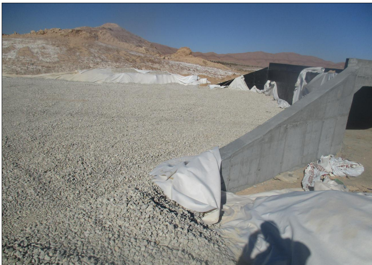
Photo n°4 : pose de la grave concassée sur le géotextile
