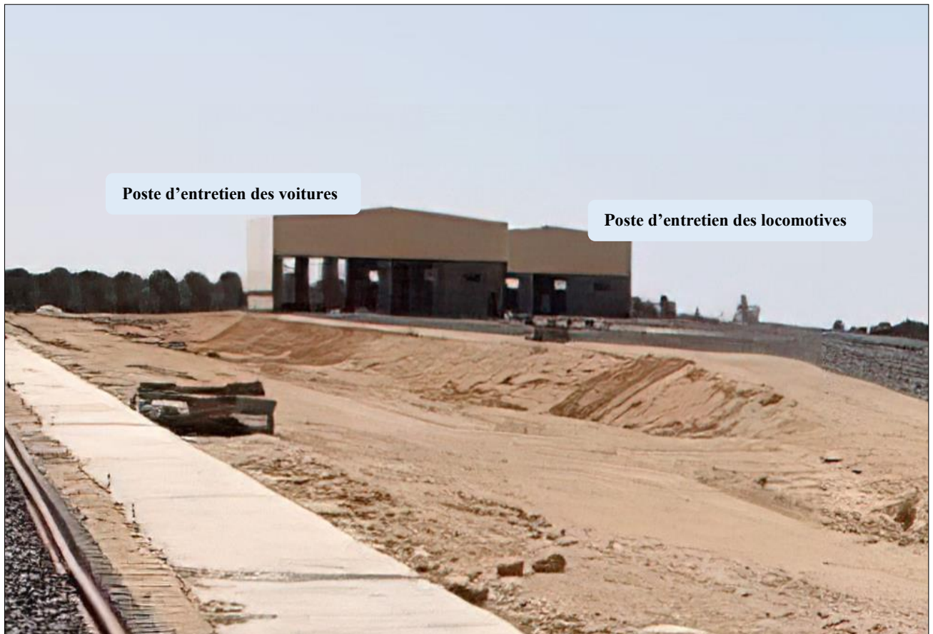
Photo n°7 : poste d'entretien des locomotives
