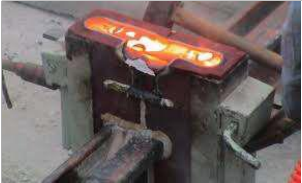
Figure III.2: Vue d'une soudure aluminothermique de rail
