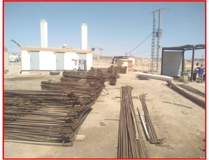
2- Ouvrage de protection de conduite d'eaux usées Ø 1200 au Pk 14+000 : les travaux de façonnage des armatures sont en cours.
