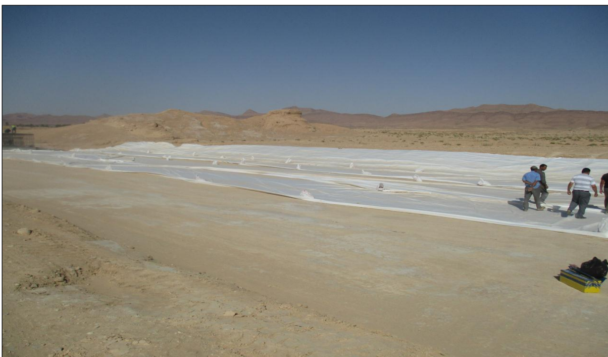
Photo n°3 : pose du géotextile
