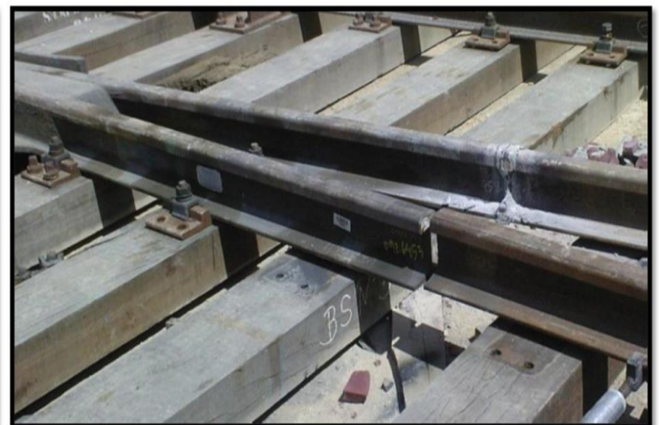
Figure I.7 : Soudure D'un Appareil De Voie En Pose
