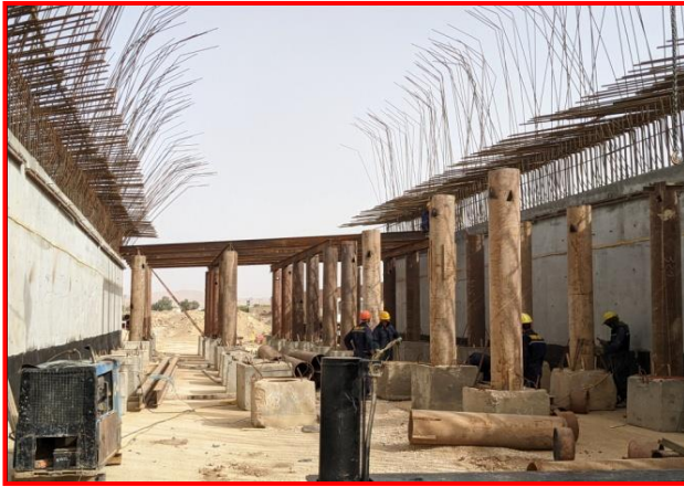
OA PK 14+134 : Travaux de coffrage de la dalle (La mise en place des pieds et des rails et la pose des panneaux de coffrage)
