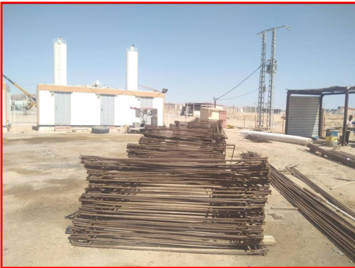
2- Ouvrage de protection de conduite d'eaux usées Ø 1200 au Pk 14+000 : les travaux de façonnage des armatures sont en cours.
