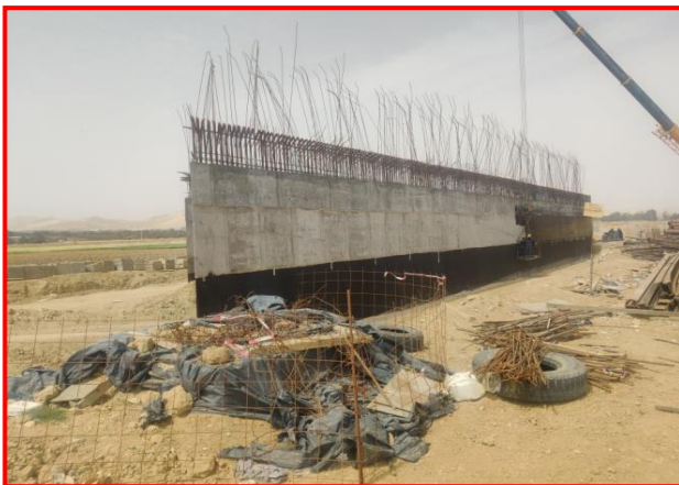
OA PK 14+134 : Travaux de coulage de voûte culé 4 ème levé côté EL-GOURZI et TOUGGOURT
