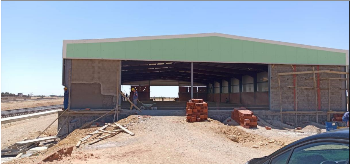
Photo n°9 :hangar de stockage
