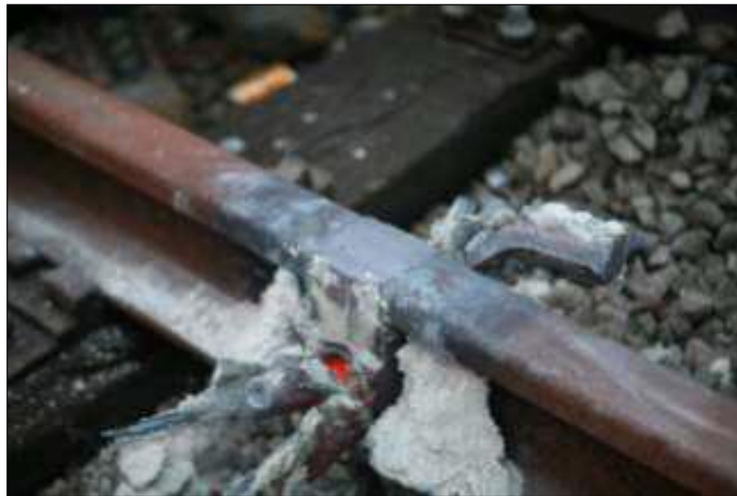
Figure III.3: Une soudure bien exécutée juste après l'ébavurage
