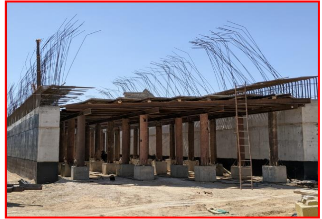
OA PK 14+134 : Travaux de coffrage de la dalle (La mise en place des pieds et des rails et la pose des panneaux de coffrage)
