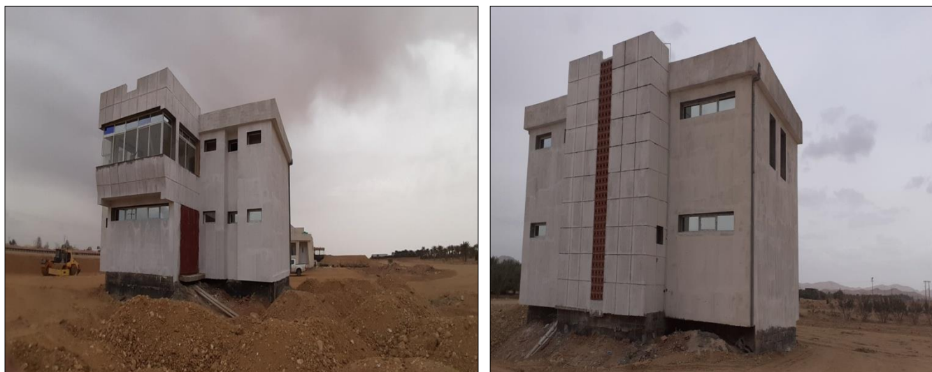
Photo n°6 :Poste de contrôle
