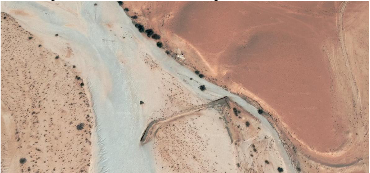
Figure III-6 Vue générale du ced Leguerabiat sur Oued El Abiod
