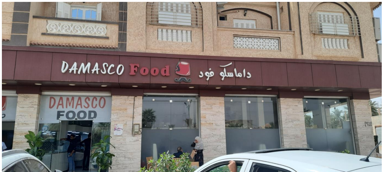
Figures n°06 : montrant l'emplacement exact du restaurant
