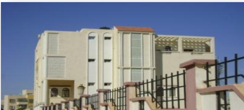
Façade Est : absence d'ouverture due : - A l'orientation - Le type d'activité des espace implante dans cette partie
