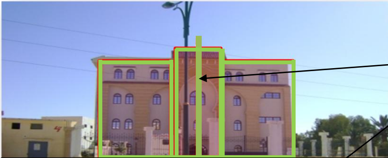
Façade Sud : la façade principale Un rythme très simple Une symétrie globale avec une dissymétrie de fenêtré
