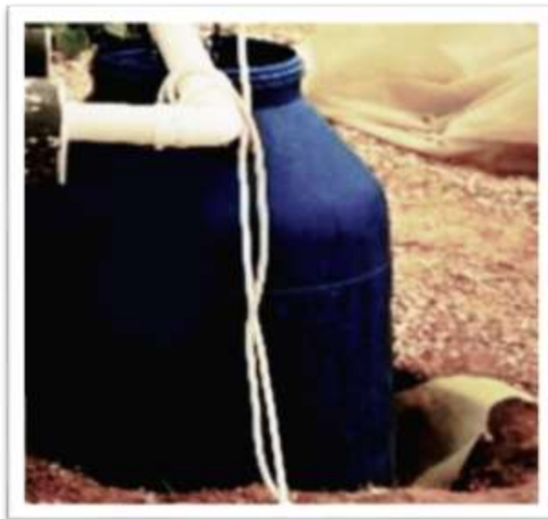
Figure 7 : Bassin de récupération
