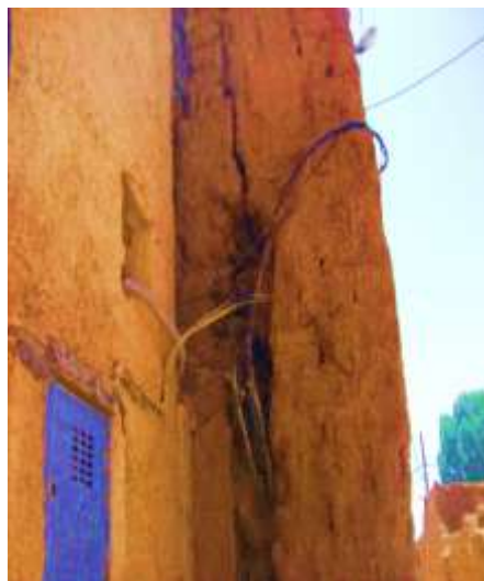
Figure IV.5 : l'épaisseur des murs (de 40 à 60 cm)
