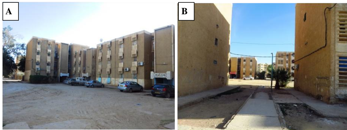
Figure (75): A/ espace public extérieur entre blocs vide et désertés. B/ Accès restreint à l'espace public extérieur entre blocs.
