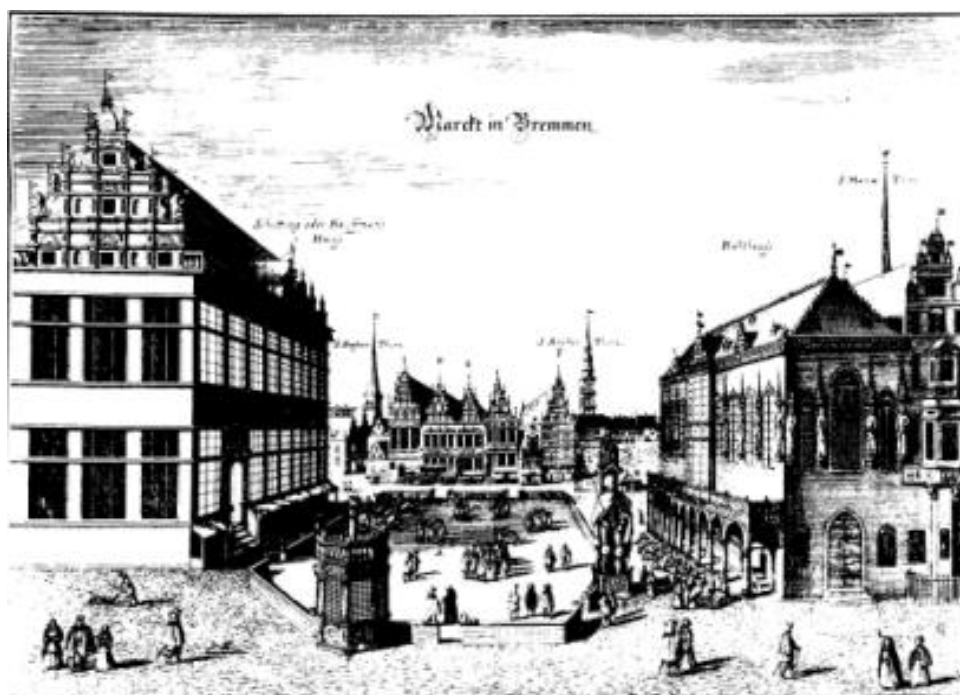
Figure (05) : Vue de place centrale de Brême (le markt) ; à gauche le palais des marchands, à droite l'Hôtel de Ville, au fond les maisons des corporations. Gravure de M. Merian , 1653.
