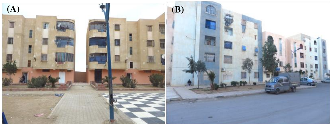
Figure (61): Les blocs du quartier 520 logements (A) bloc en R+3, (B) bloc en R+4
