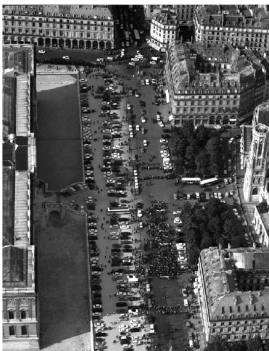
Figure (09) : L'envahissement du parking le long du musée du Louvre, coté rue de l'Amiral Coligny, Paris, en 1950. Source: APUR, 2011, p 2.
