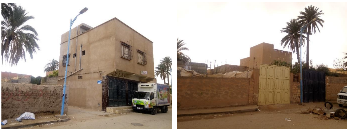
Fig.31 : Les nouvelles constructions dans la palmeraie
