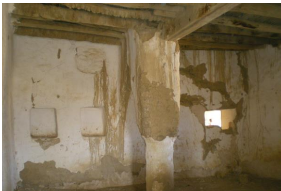
Figure III.22 : Mosquée, vue intérieure avant la restauration. (Source :Dali.A,2011).
