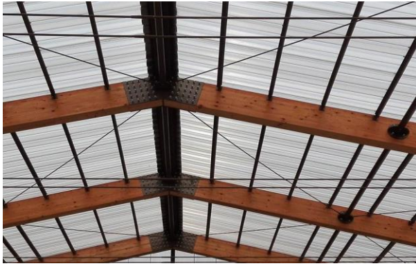
Figure. VII.19: Couverture d'une partie de la villa . (Source : Auteur ,2017)
