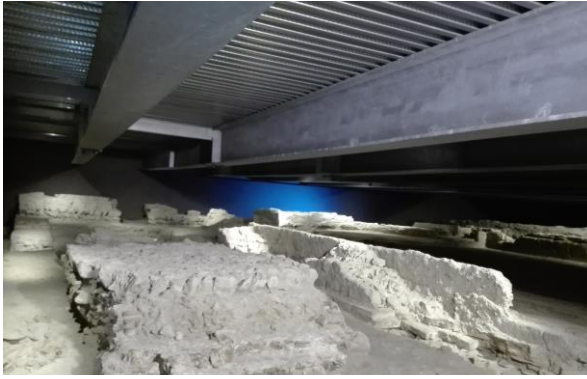
Figure. VII.24 : Structure protectrice . (Source : auteur, 2017)
