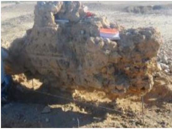
Figure.III.40 : Mur d'une salle des thermes avant la restauration. (source :Hadji,2013)
