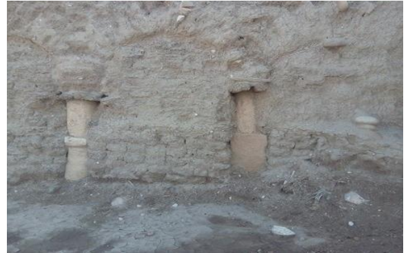
Figure III.21 : Mur ouest, vestiges de quatre arcatures comblées, reposant sur des fragments de quatre colonnes antiques et leurs chapiteaux.(Source :auteur,2016).
