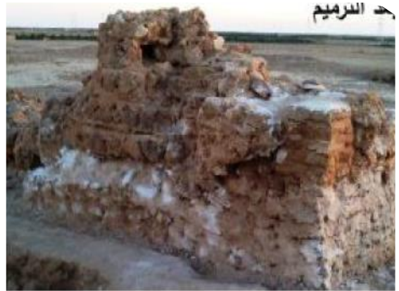
Figure III.41 :Mur d'une salle des thermes après la restauration. (source :Hadji,2013).
