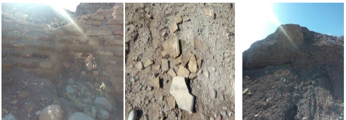
Figure IV.16 : L'état actuel des constructions romaines. (Source : auteur,2016).
