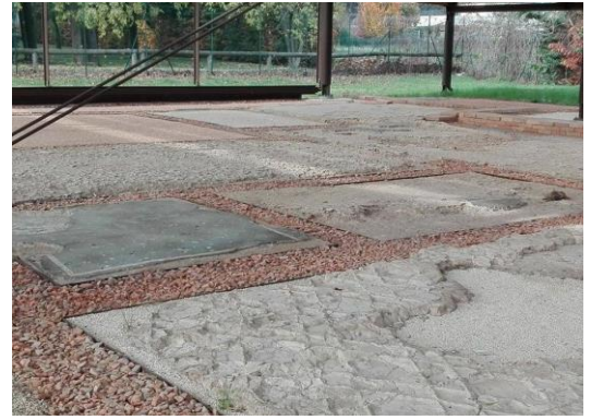
Figure. VII.20 : Traitement du sol de la villa . (Source : Auteur ,2017)
