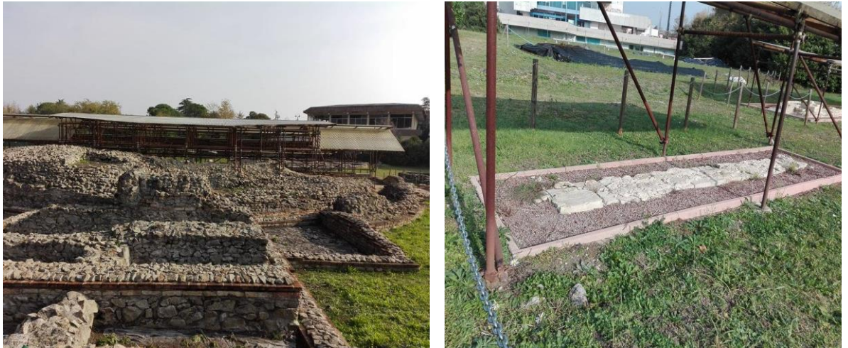
Figure VII.15 : Structures de protection. (Source : Auteur ,2017)
