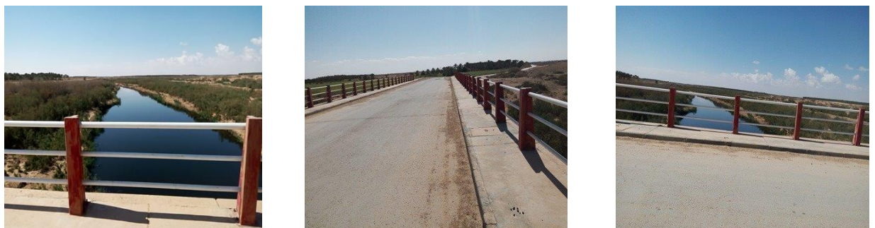
Figure IV.31: Le nouveau pont qui mène directement au site. (Source : Auteur,2017)
