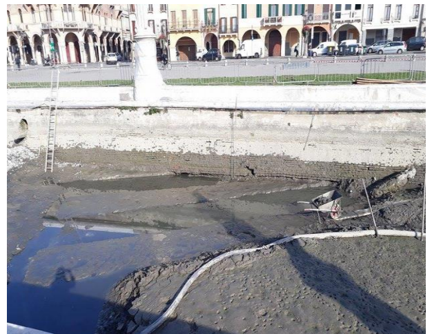
Figure. VII.12 : L'aspiration du canal lors des travaux de fouilles du théâtre romain à Padova . (source :Auteur,2017)
