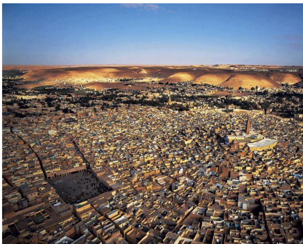
Fig. V.2. vue aérienne du Ksar de Ghardaïa (Arthus-Bertrand, 2014).
