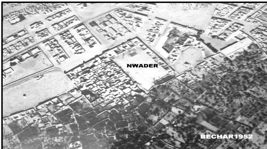
Figure 5.11: Vue aérienne du ksar et la palmeraie. [Source : bibliothèque personnelle de Hamadi A].
