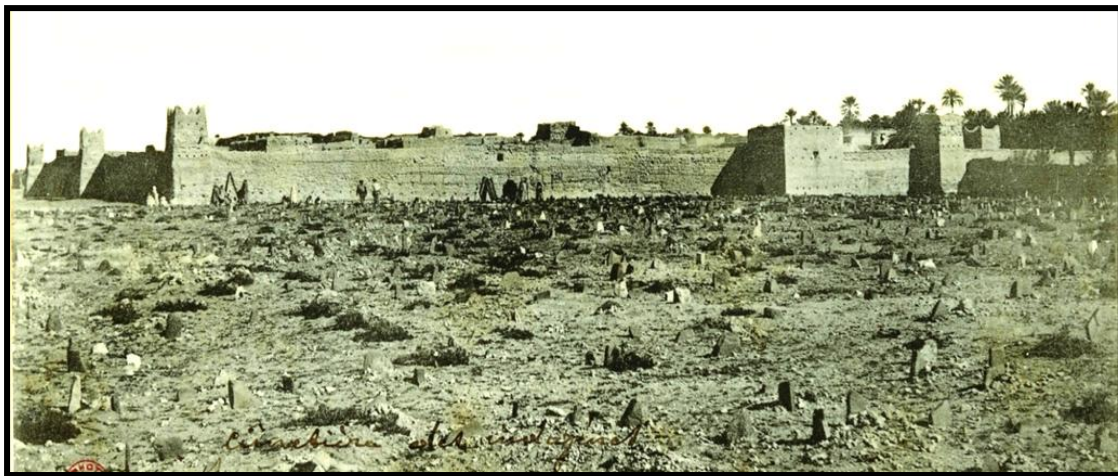
Figure 5.7 : vue sud ouest.
