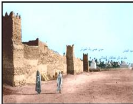
Figure 5.8 : vue ouest du ksar en 1903.
