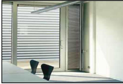
**Figure I-19** : Ouvrant de ventilation naturelle avec grille pare-pluie. **Source** : (Doc. Renson).
