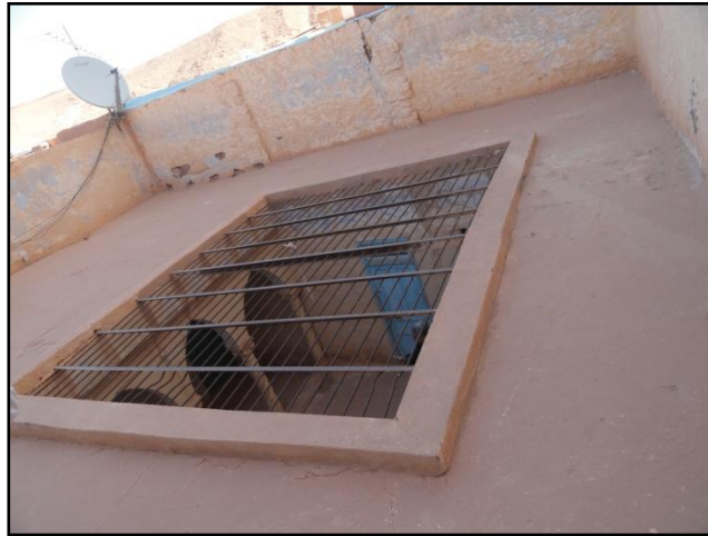
Figure 1.9 : Le chebek dans la maison mozabite (Source: Auteur, 2011)
