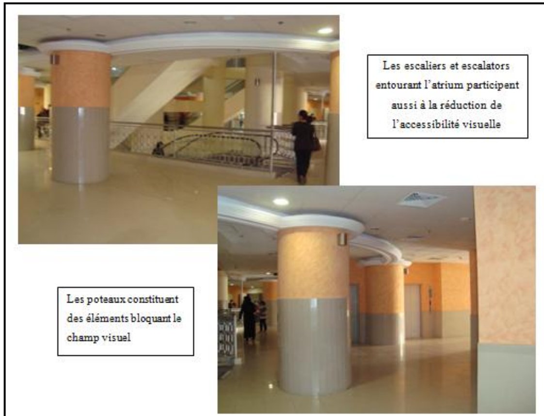
Fig. V. 28 : Des vues sur l'atrium et les escaliers : les escaliers et les poteaux constituent un obstacle bloquant le champ visuel des usagers du centre. Source : Auteur, 2012.
