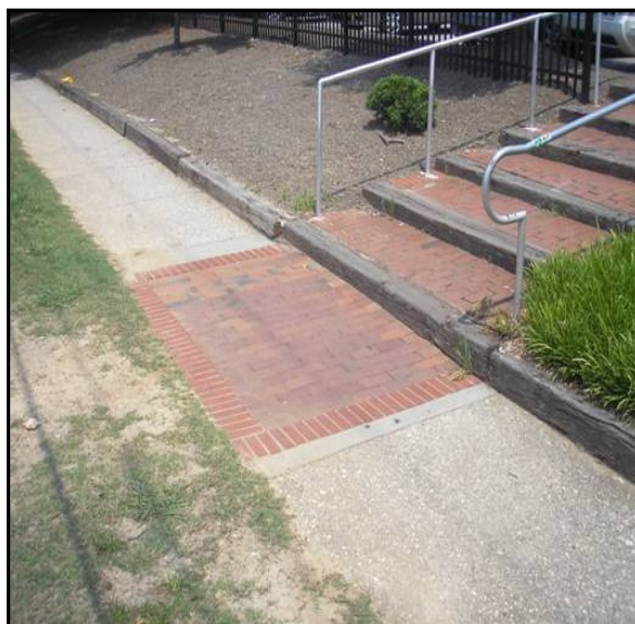
Fig. III.8. Trottoir en béton avec un motif de brique (changement de matériau).mis en place pour identifier l'emplacement d'un escalier. Source : Payne, 2005.
