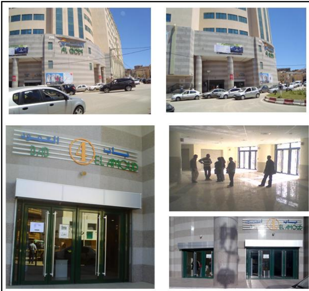
Fig. V. 24: Différentes vues sur les principales entrées du centre. Source : Auteur, 2012.
