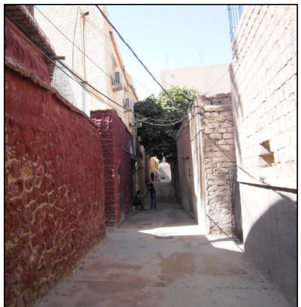
Photo 34 : Rue de djamaa Ennakhla. Source : Auteur, 2011
