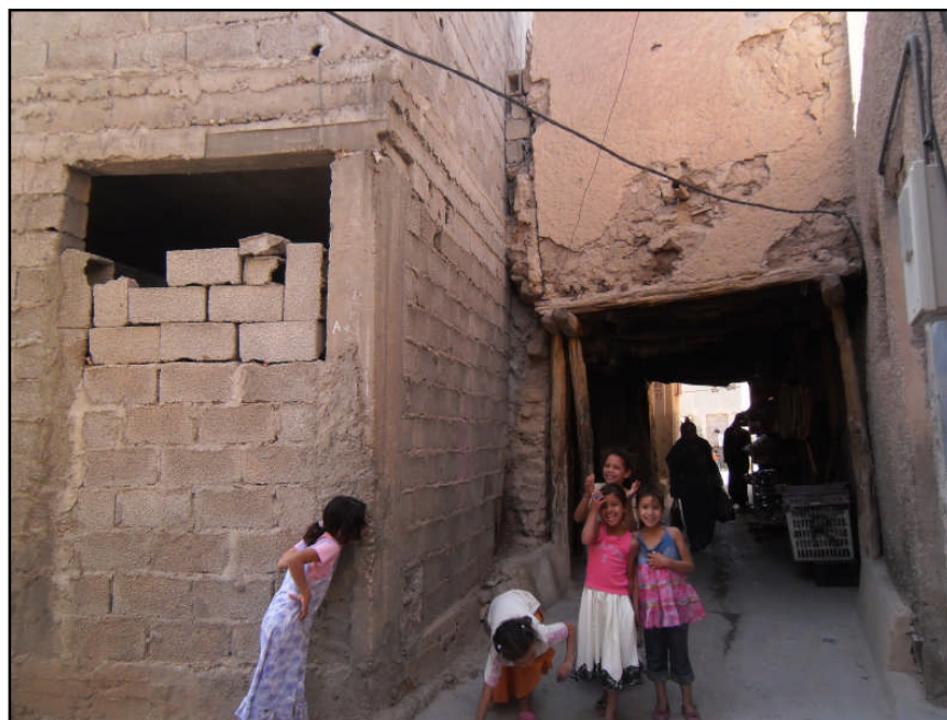
Photo 39 : L'adoption des nouveaux procédés et matériaux de construction exogènes dans la médina de Bou-Saada. Source : Auteur, 2011
