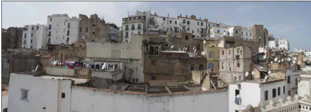
Photo 14 : La prolifération des nouvelles constructions dans la Casbah d'Alger Source: (Rehabi-Med, 2007)
