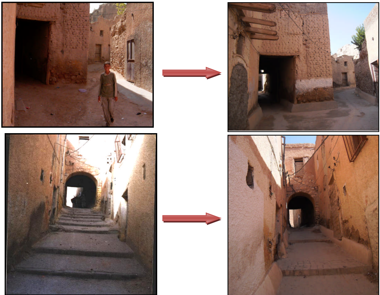
Photos 44 : Les voiries de la médina de Bou-Saada, avant et après la réalisation des travaux de VRD. Source : Auteur, 2011
