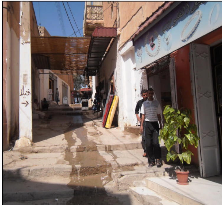
Photo 42 : L'introduction des nouveaux éléments exogènes, (le poteau électrique, l'enseigne publicitaire, ...), dans une rue dans la médina de Bou-Saada. Source : Auteur, 2011
