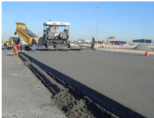
Figure I. 8. Béton de sable compactant au roulant
