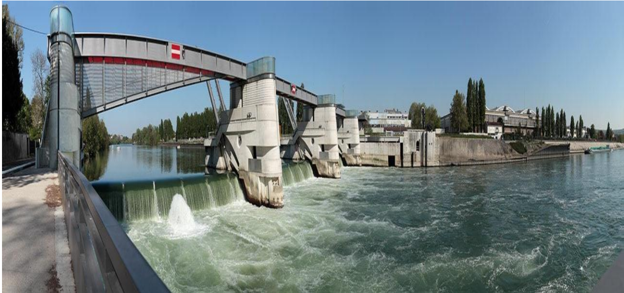
Figure 1.5 : Barrage de Chatou-France [29]
