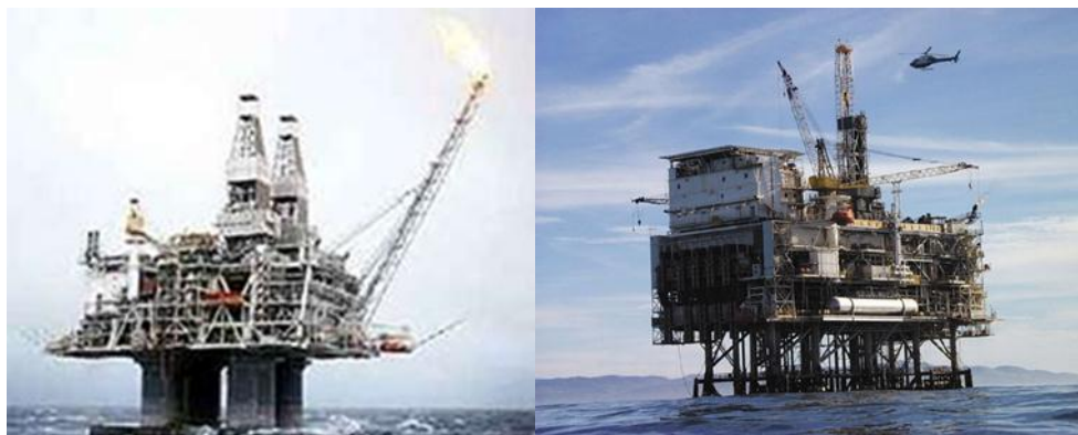
Figure (II.5) : Plateforme pétrolière Hibernia [97].
