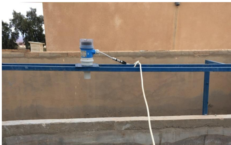
Figure I.6. Détecteur de niveau à ultrason.
