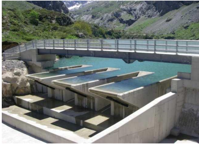
Figure II.43. Un barrage avec un déversoir de type Piano Key Weir.
