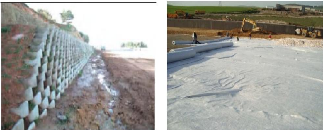
Figure 1.20 Exemple de renforcement par des géosynthétiques
