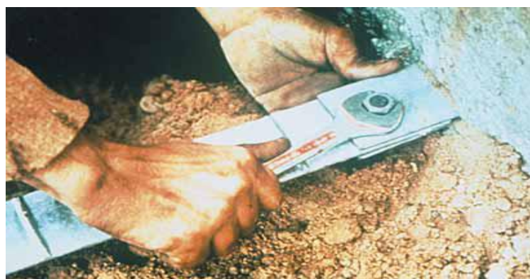
Figure 1.35 Dispositif de fixation d'une armature métallique
