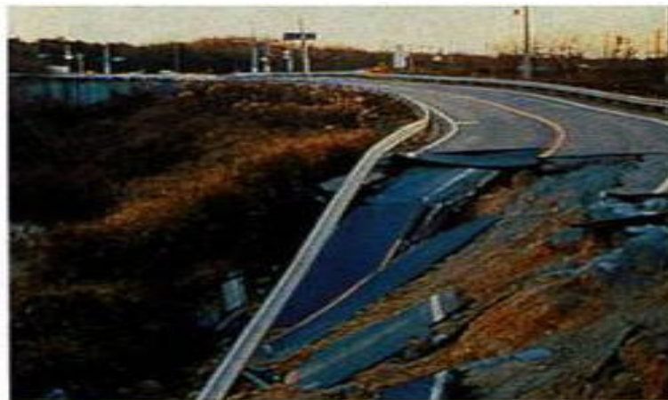
Figure 2.5 Rupture d'un massif renforcé
