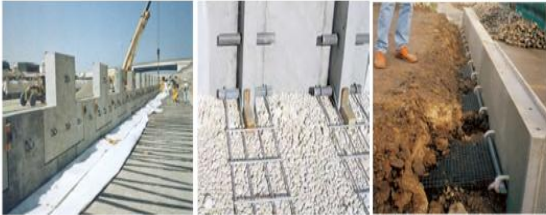
Figure 1.36 Dispositifs de connexion des renforcements géosynthétiques/parement
