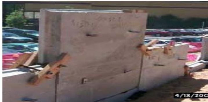
Figure 1.32 Installation des serre-joints sur les écailles placées
