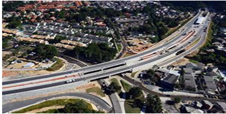
Figure 1.22 Construction des murs en Terre Armée au Brésil en 2016
