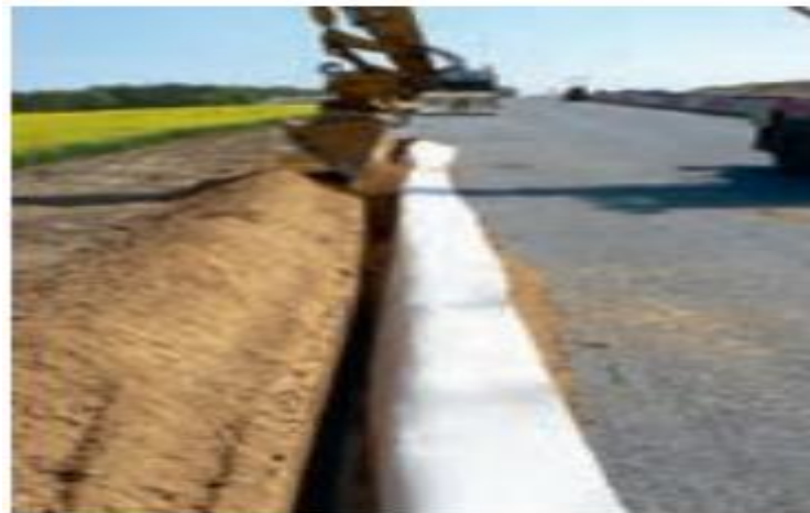
Figure 1.17 Géocomposite de drainage d'une chaussée
