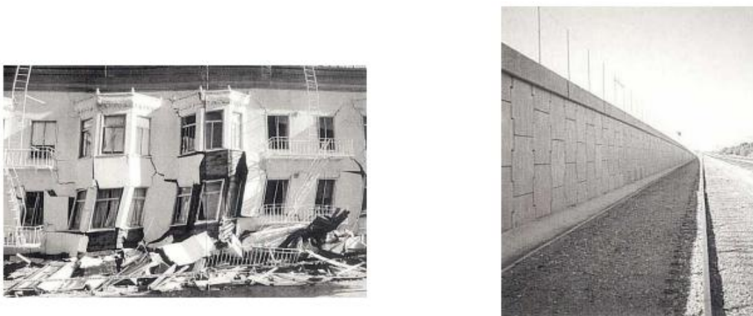
Figure 3.17 Photos de maisons écroulées dans le quartier des Marinas à San Francisco et d'un mur en terre armée à Richmond
