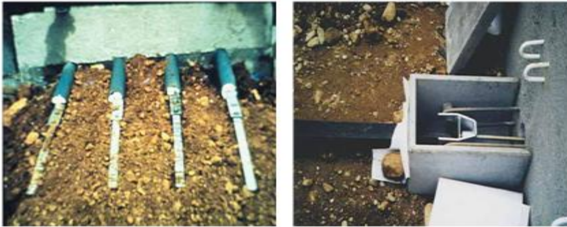
Figure 1.51 Pose des témoins de durabilité de renforcements métalliques et géosynthétiques
