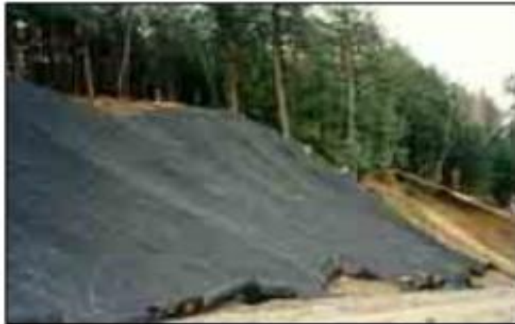
Figure 1.19 Géotextiles en protection avant recouvrement de la terre végétale
