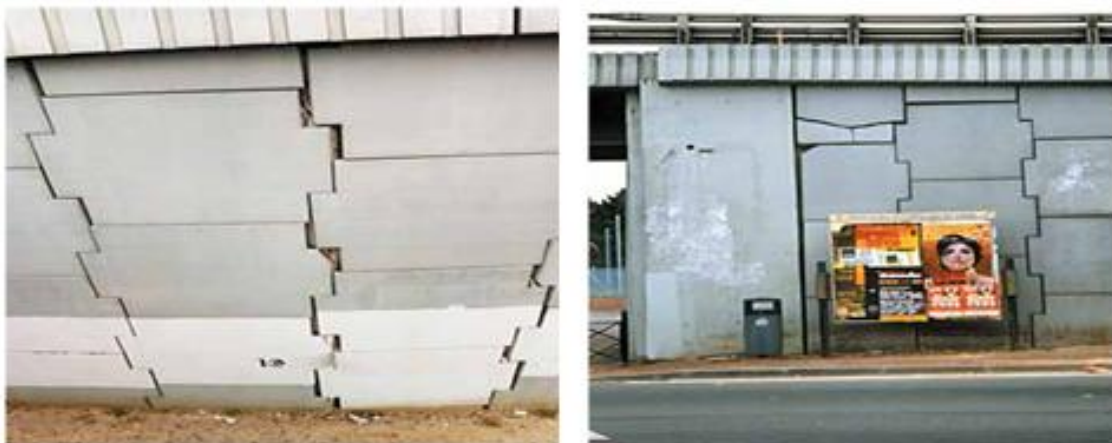
Figure 1.52 Mouvement d'écailles dû à un tassement différentiel, sans et avec fracturation du parement
