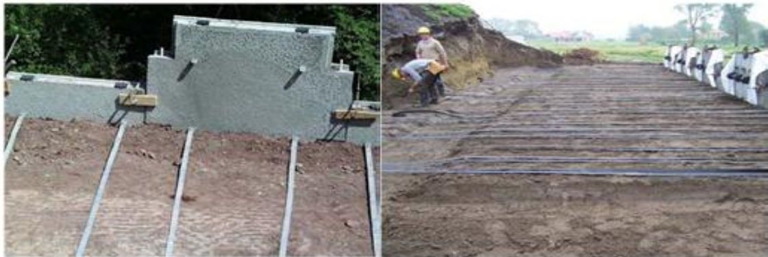
Figure 1.34 Pose du premier lit d'armature
