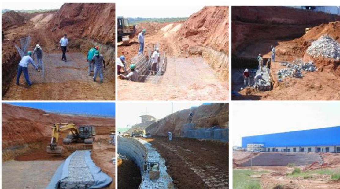
Figure 1.41 Processus de construction d'un mur « Terramesh »
