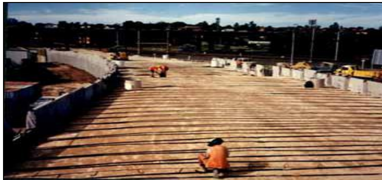
Figure 5.1 Construction d'un remblai d'accès avec un mur à double parement
