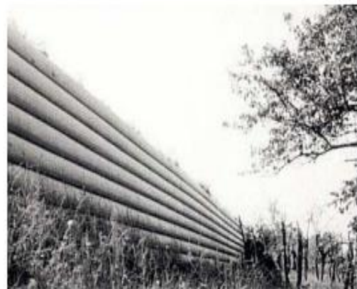
Figure 3.15 Photos d'une maison en ruine à Gemona et d'un massif de soutènement à parement métallique près de Gorizia
