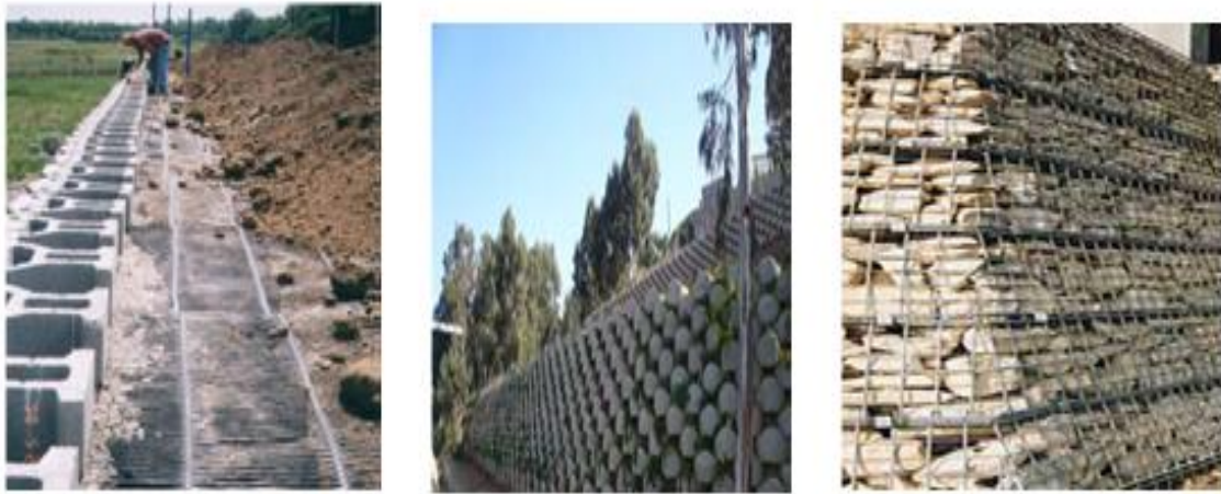
Figure 1.25 Parement en blocs préfabriqués et en grillage d'acier
