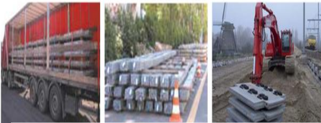
Figure 1.28 Déchargement et stockage des panneaux
