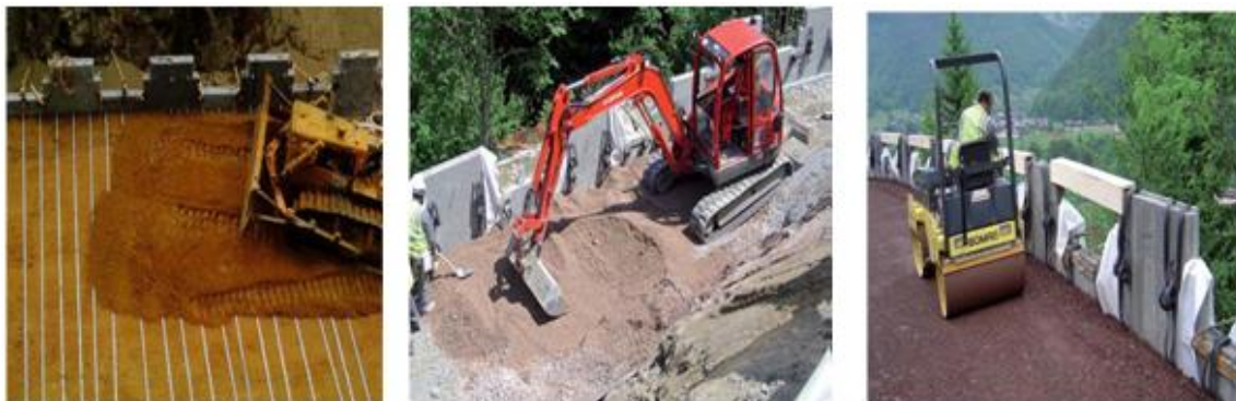
Figure 1.33 Remblaiement et compactage
