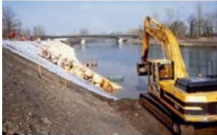
Figure 1.16 Géotextile de filtration sous enrochement
