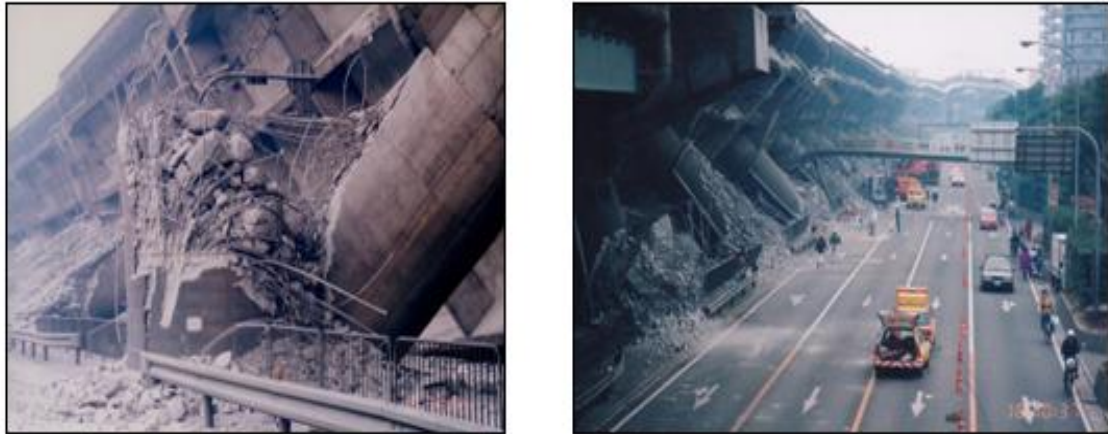
Figure 3.18 Effondrement du viaduc de Fukae [Koseki, 2002]
