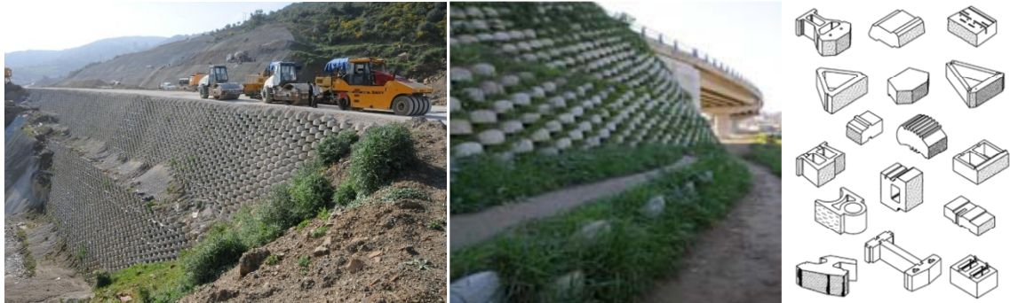
Figure 1.23 Mur de soutènement en blocs modulaires
