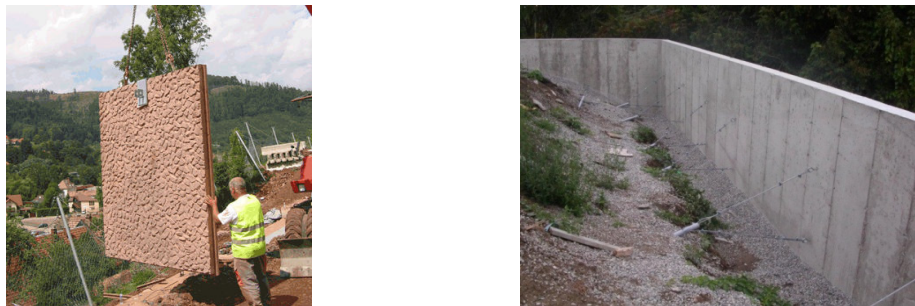
Figure 1.20 Panneaux de pleine hauteur
