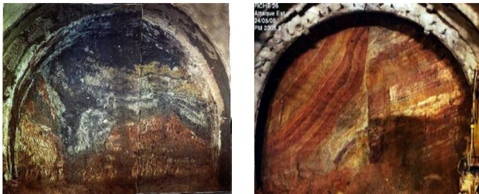
Figure 3.3 : Front de taille du tube Sud (Le Bissonnais et al., 2008).
