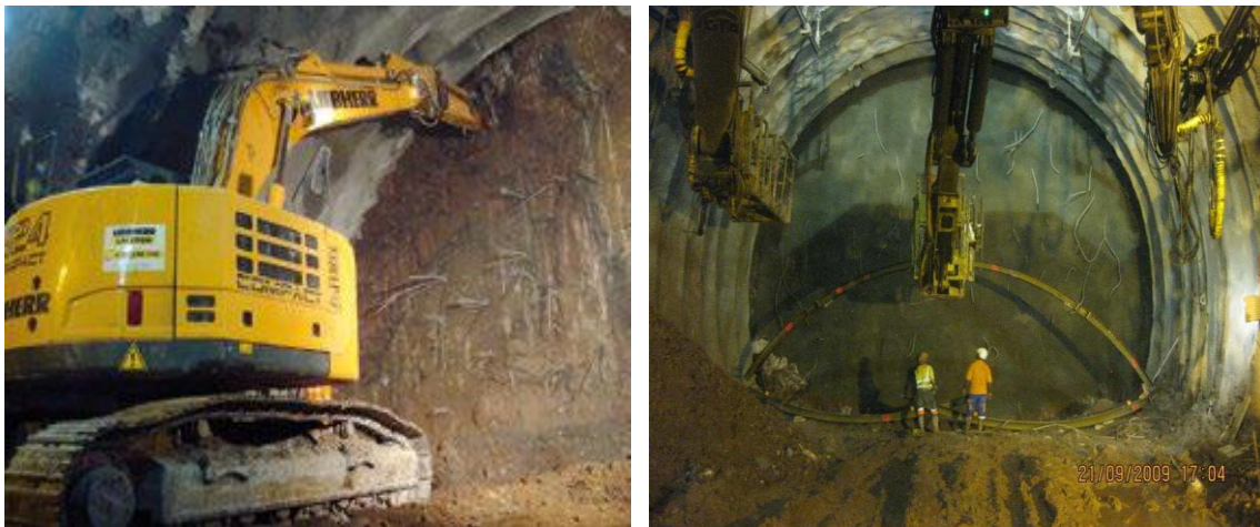
Figure 3.8 : L'excavation et pose du cintre (DREAL PACA, 2015).
