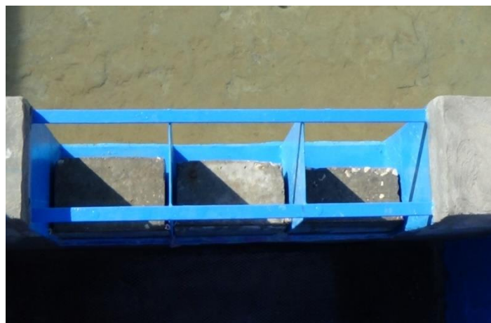
Figure III.13 Installation des trois blocs sur le déversoir
