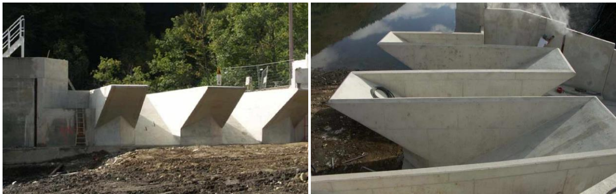
Figure I.6 Déversoir en touches de piano (PK-Weir) sur le barrage de Goulours (EDF- Electricité de France. Octobre 2006)
