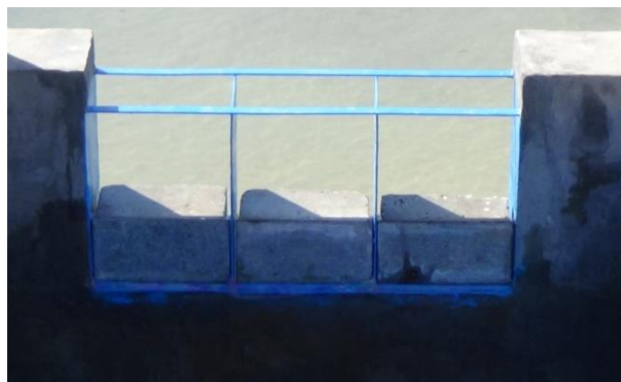
Figure III.12 Vue de l'aval d'un support qui se compose de trois blocs
