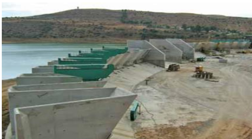
Figure I.10 Hausses fusibles à seuil labyrinthe sur le barrage Ghrif en Algérie (Hydroplus, France)
