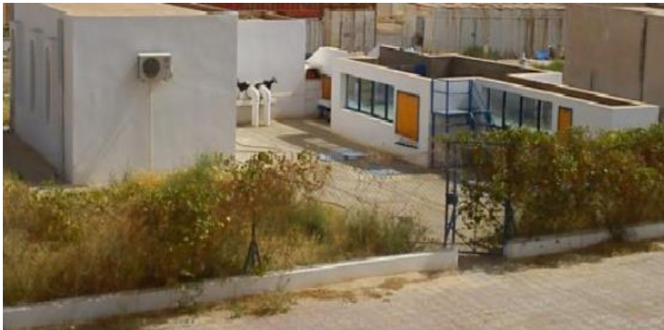
Figure III.1 Vue d'ensemble de la station d'expérimentation des modèles réduits
