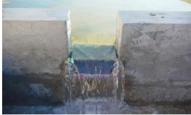
Figure III.11 Vue de l'aval de l'écoulement sur le bloc fusible avant basculement
