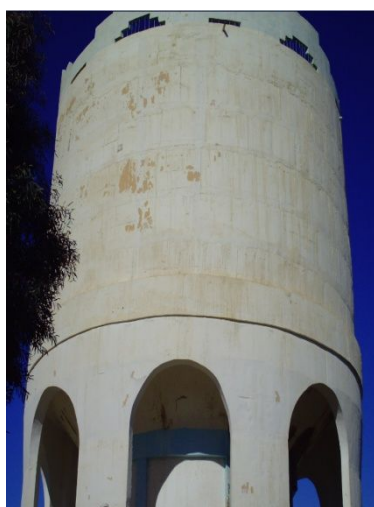
Photo III.8 : Château d'eau, 400 logements
