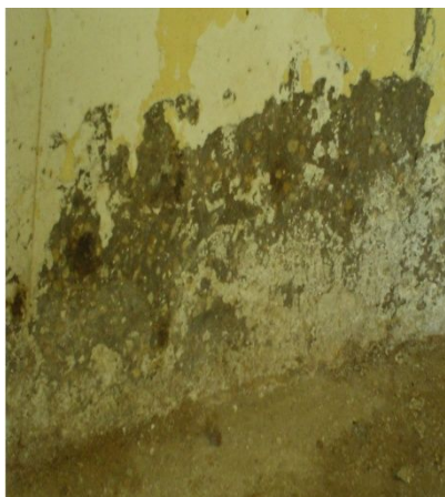
Photo III.9 : Traces de rouille sur voile en BA
