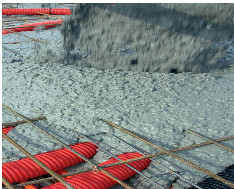
Photo 1.1 : Durant le coulage du BAP dans une dalle encombrée, les gravillons nagent sans aucune ségrégation [20].
