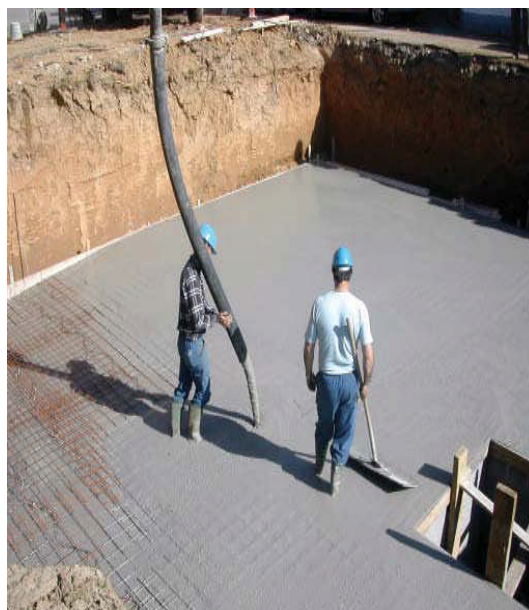
Photo 1.3 : Le serrage du BAP est réalisé sans apport de vibration.
