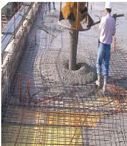
Photo 1.2 : Mise en place de BAP au moyen d'une benne par un seul ouvrier.
