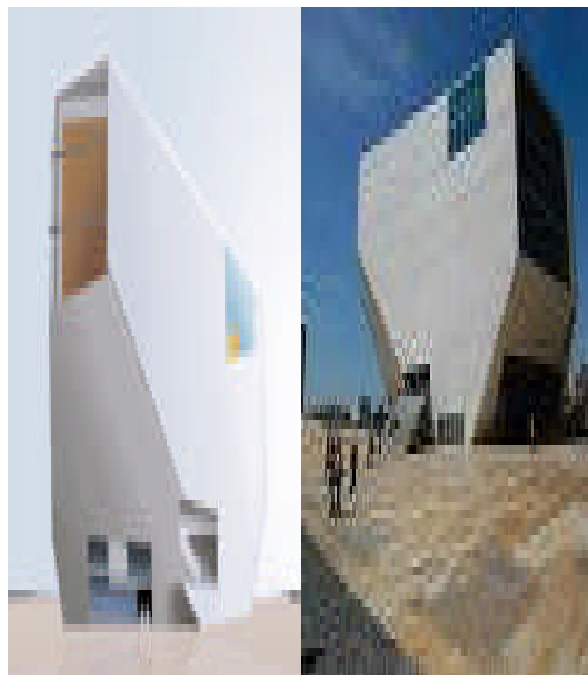
Photo 1.5 : La maison de la musique à Porto représente un cristal, nécessitant 20000 m 3 de BAP blanc.
