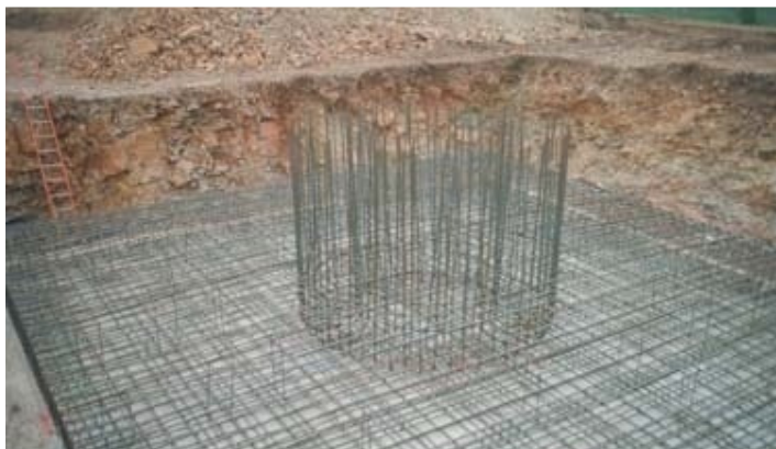
Figure 1.9 : Fondations d'une éolienne
