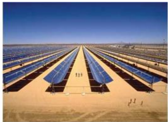
Figure I.6 : Des installations solaire avec des capteurs cylindro-paraboliques [8, 9].
