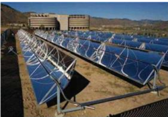
Figure I.6 : Des installations solaire avec des capteurs cylindro-paraboliques [8, 9].
