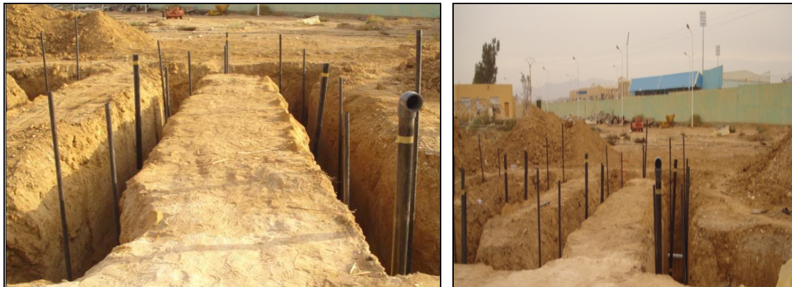
Figure III.9 : Tranchées pour installation de l'échangeur enterré air/sol
