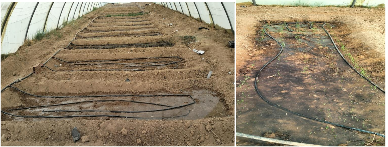
Figure 09: Installation de système d'irrigation
