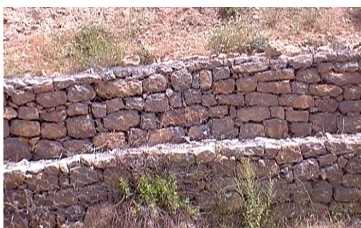
Photos n° 2. Seuil de sédimentations en Gabions et en pierres sèches (Cliché Aouachria M.)
