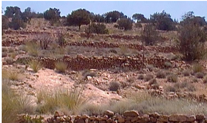
Photo n° 1. Seuil de sédimentation en murettes de la pierre sèche (Cliché Aouachria M.)
