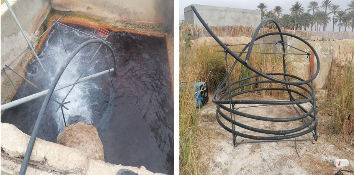
Figure III.2: Échangeur de chaleur monotube de 22 m de long (deuxième expérience de chauffage de l'air 19/03/2024)
