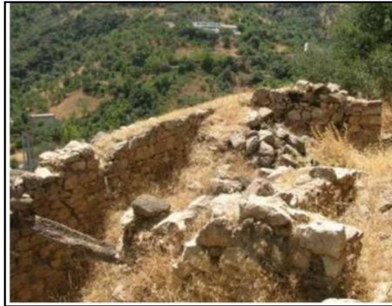
Figure 3 - 12 : Exemple d'une bâtisse totalement effondrée.
