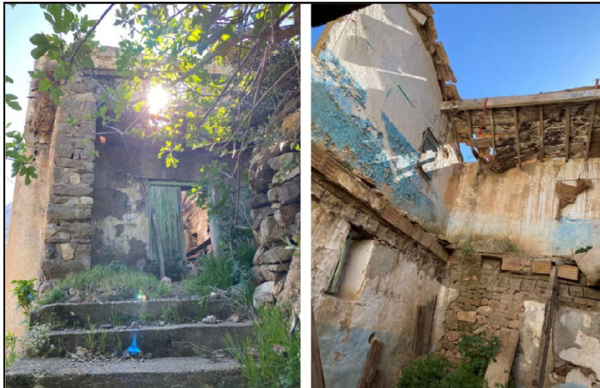
Photo 3 - 11 : Maisons traditionnelles partiellement effondrées dans le sous-secteur II de Ait El Kaid. Source : Auteure, 2023.
