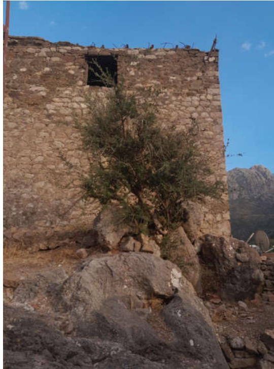
Photo 3 - 5 : Ancienne mosquée du village Ait El Kaid. Source : Auteur, 2019.
