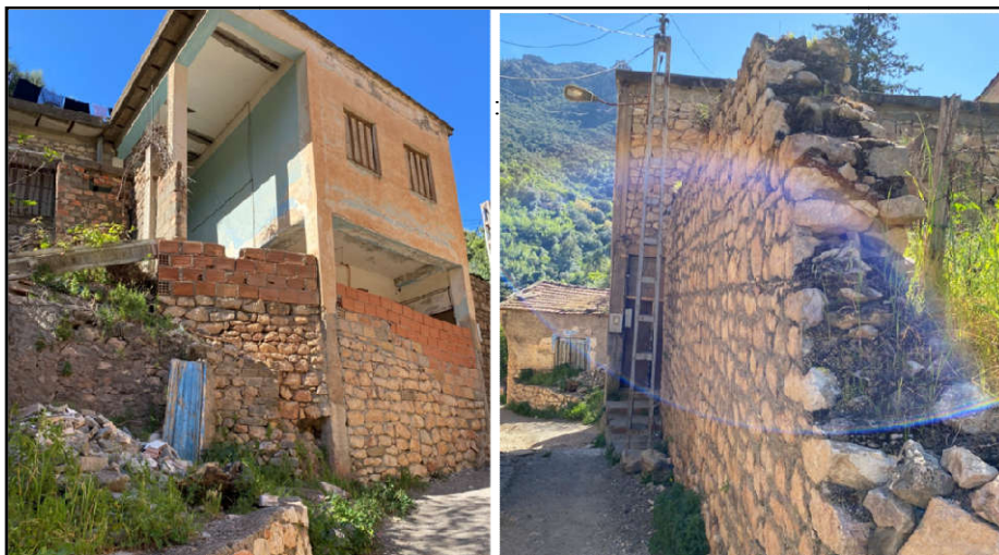
Photo 3 - 12 : Maisons contemporaines bâti sur des maisons traditionnelles dans le sous-secteur II de Ait El Kaid. Source : Auteure, 2023.
