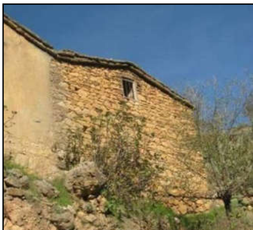
Figure 3 - 11 : Exemple d'une bâtisse traditionnelle relativement stable.
