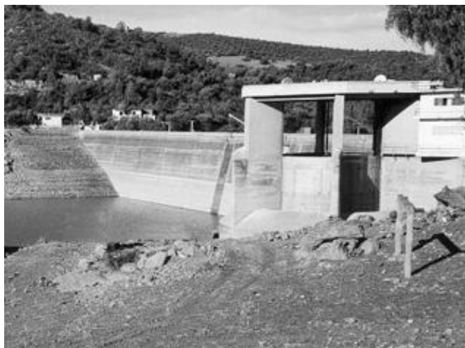
Figure 3 : Une vue du barrage de Hamiz (Source ANBT)
