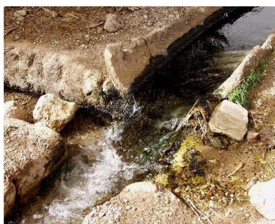
Fig 3: photo d'une saguiat non bétonnée, photo prise par l'auteur du rapport.
