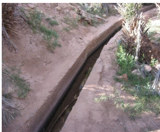
Fig 2: photo d'une saguiat bétonnée, photo prise par l'auteur du rapport.
