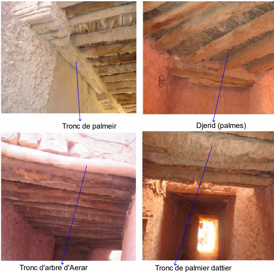
Figure 3 : Toiture du ksar réalisé par les dérivées du dattier (Auteurs, Mai 2015)
